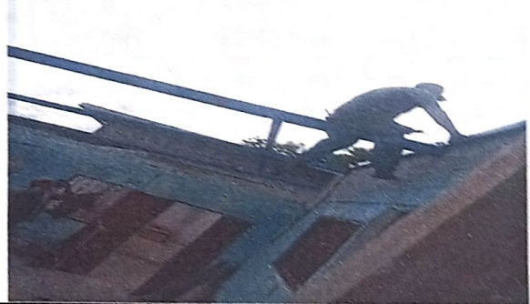
Foto 6: INSTALACIÓN DE ESTRUCTURA DE METAL
