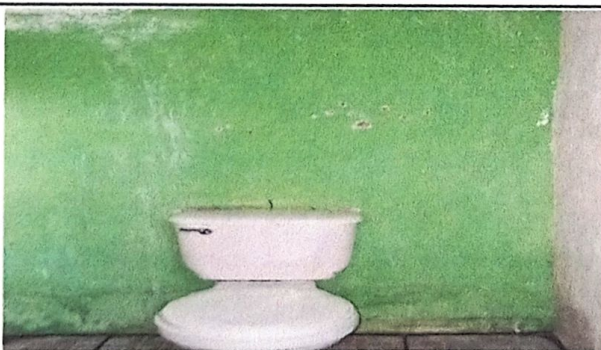
Foto 5: instalación de inodoros
