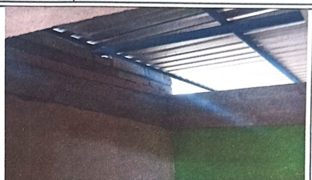
Foto 2: sustitución de estructura de madera, por lámina troquelada calibre 26 aluzinc.
