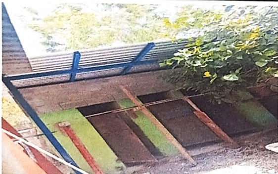
Foto 3: Sustitución de estructura de madera por soporte de metal.
