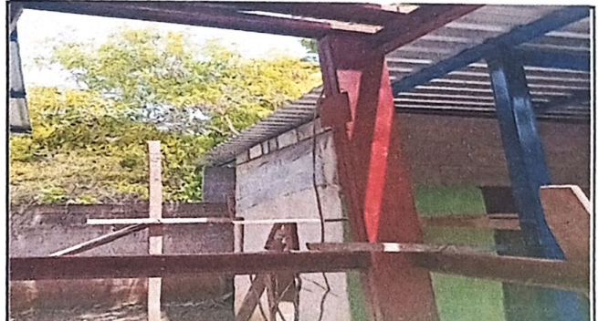
Foto 4: sustitución de lámina ondulada por lámina troquelada calibre 26 aluzinc
