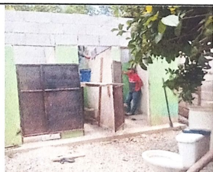
Foto 6: instalación de muros de block (subirle al muro dos hiladas de block)
