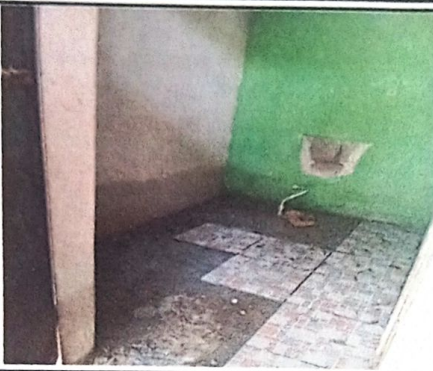
Foto1: Instalación de piso cerámico Mate
