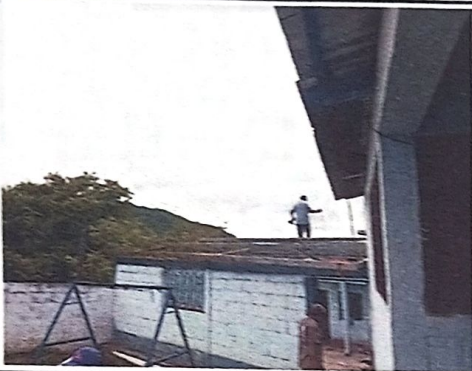
Foto1:SUSTITUCIÓN DE ESTRUCTURA DE MADERA POR SOPORTE DE METAL
