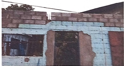
Foto 4: INSTALACIÓN DE MUROS DE BLOCK (SUBIRLE AL MURO)
