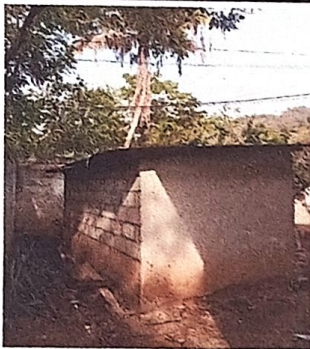
Foto 9: Sustitución de Lámina Ondulada por Lámina Troquelada en Baños
