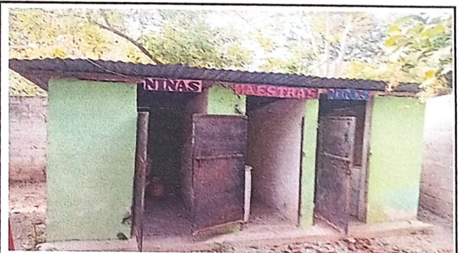
Foto 10: Sustitución de Estructura de Soporte de Madera por Metal en Baños
