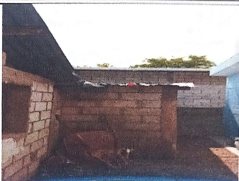
Foto 2: Sustitución de Lámina Ondulada por Lámina Troquelada en Cocina
