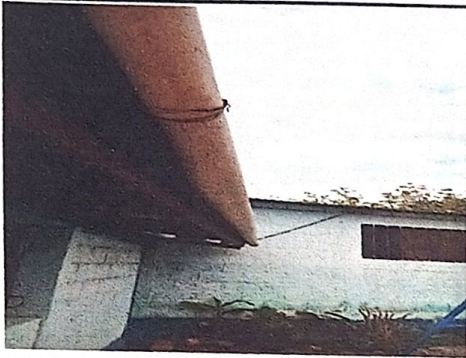
Foto 7: Instalación de Canal de Metal y Bajadas de Aguas Pluviales en Cocina
