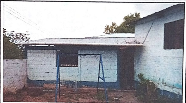
Foto 8: Sustitución de Lámina Ondulada por Lámina Troquelada en Cocina
