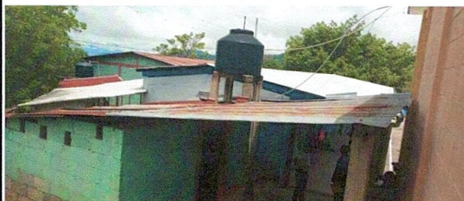
Foto 1: Sustitución de lámina en cocina.
