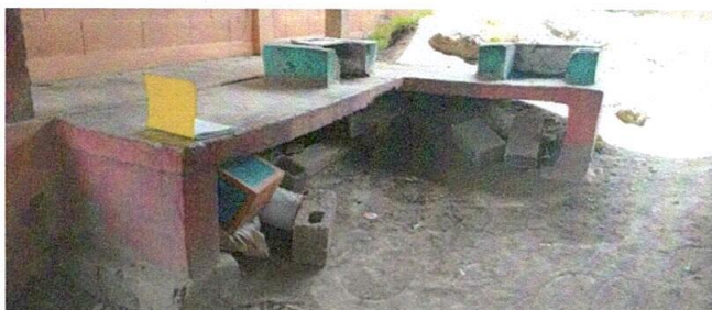
Foto 5: Sustitución de mueble de concreto e instalación de azulejo en cocina.
