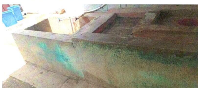
Foto 4: Sustitución de pila de block en cocina.
