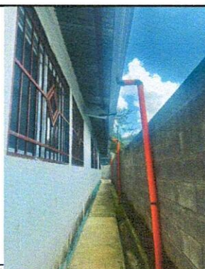
Foto 5: Instalación de canal de metal en aulas.
