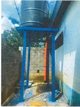
Foto 7: Área para instalación de estructura de metal para depósito de agua y red de tubería para distribución en baños
