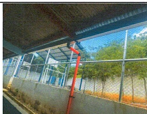
Foto 4: Instalación de canal de metal en aulas
