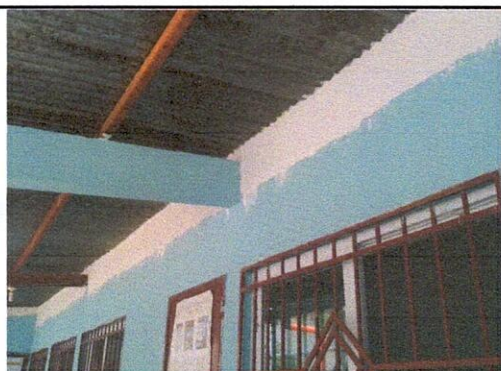
Foto 3: Repellos, cernidos y entabicado de muros (Cierre de espacio entre pared y lamina) en aulas.
