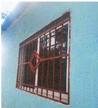
Foto 1: Instalación de ventanas PVC en aulas.
