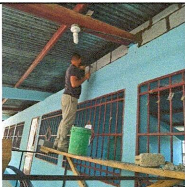
Foto 3: Repellos, cernidos y entabado de muros (Cierre de espacio entre pared y lamina) en aulas.
