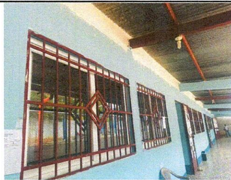
Foto 2: Instalación de ventanas PVC en aulas.
