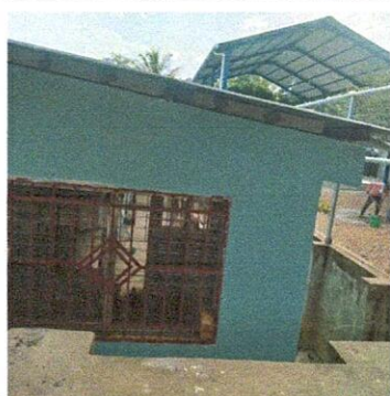
Foto 5: Instalación de canal de metal en aulas.
