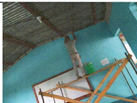
Foto 6: Repellos, cernidos y entabado de muros (Cierre de espacio entre pared y lamina) en aulas.
