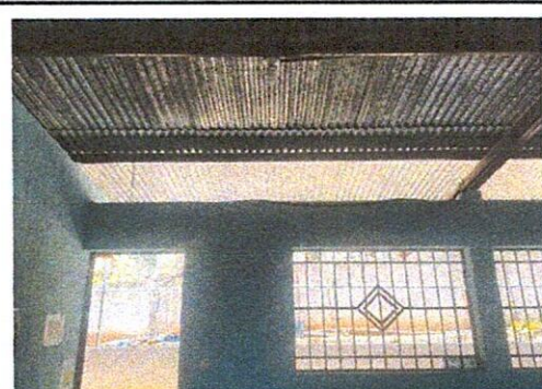
Foto 6: Repellos, Cernidos y Entabicado de Muros (Cierre de Espacio entre Pared y Lámina) en Aulas
