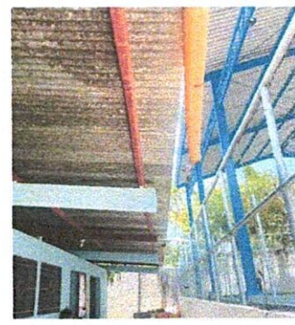
Foto 4: Instalación de Canal de Metal en Aulas
