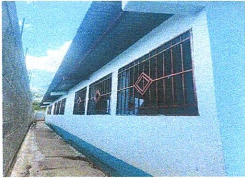
Foto 1: Instalación de Ventanas PVC en Aulas
