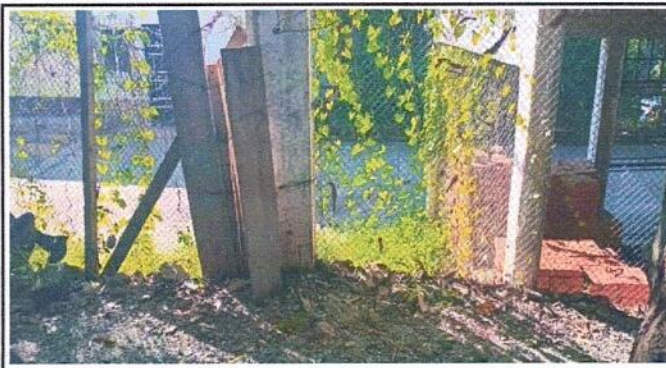
Foto 8: Suministro, instalación de muro de Block. Los trabajos son para poder contar con una salida de emergencia.
