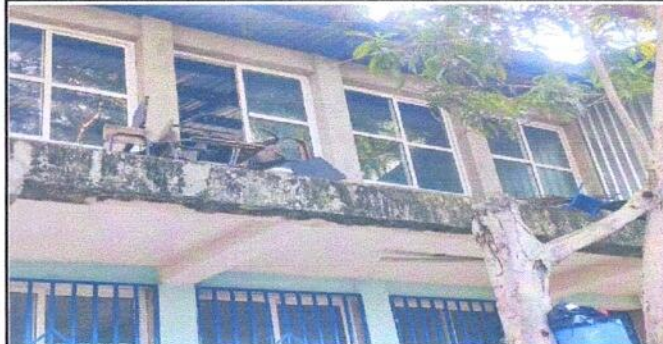
Foto 2: Suministro, instalación de lámina y estructura de metal en aulas. Los trabajos servirán para echar la ampliación del área de peligro.
