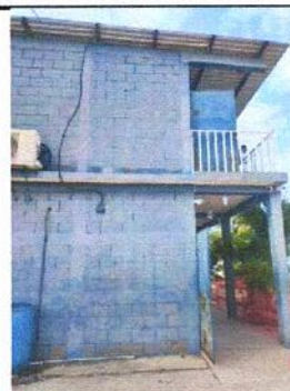
Foto 6: Pintura de muro interiores y exteriores
