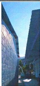
Foto 3: Suministro, instalación de canal de metal en aulas.
