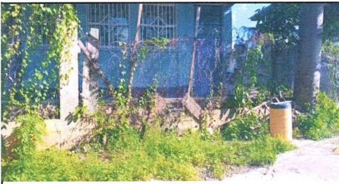
Foto 10: Suministro, instalación de columnas de concreto y hierro para instalación de portón de metal.
