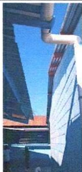
Foto 1: Suministro, instalación de lámina y estructura de soporte de metal en aulas. Los trabajos servirán para cerrar los espacios entre aulas.
