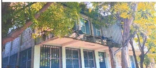
Foto 4: Suministro en cierre de espacios en terraza con estructura de soporte de metal.
