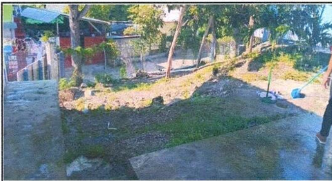
Foto 7: Cortes de terreno, nivelación, compactación y fundición de planchas de concreto, en rampa de acceso de Emergencia.
