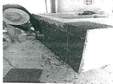
Foto 2: SUSTITUCIÓN DE PILA DE PLÁSTICO POR PILA DE BLOCK Y CONCRET.O E INSTALACIÓN DE AZULEJO EN COCINA
