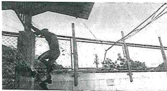
Foto1: INSTALACIÓN DE CUADROS DE MALLA Y TUBO PROCESO EN MURO PERIMETRAL
