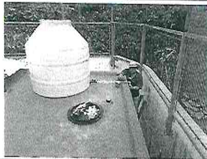
Foto 4: SUSTITUCIÓN DE CISTERNA Y DE RED DE DISTRIBUCIÓN DE AGUA POTABLE EN BAÑOS
