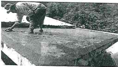
Foto 5: LIMPIEZA, NIVELACIÓN E IMPERMEABILIZACIÓN EN TERRAZA DE BAÑOS.
