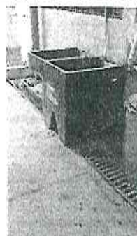
Foto 2: SUSTITUCIÓN DE PILA DE PLÁSTICO POR PILA DE BLOCK Y CONCRETO E INSTALACIÓN DE AZULEJO EN COCINA
