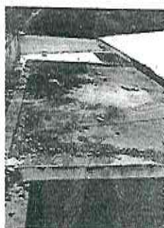
Foto 5: LIMPIEZA, NIVELACIÓN E IMPERMEABILIZACIÓN EN TERRAZA DE BAÑOS.
