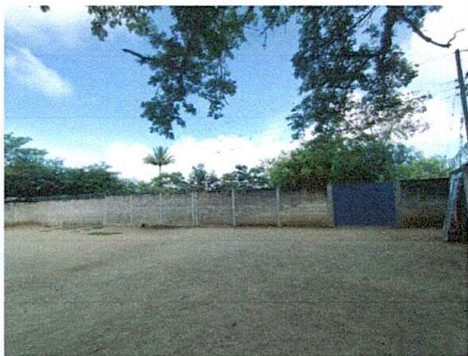
Foto1: Preparación de terreno para planchas de cemento
