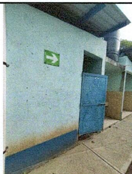
Foto 5: Mantenimiento a puertas de metal (Lijado, cambio de tubo, cepillado y aplicación de pintura) de 1,3 mts2 cada una.
