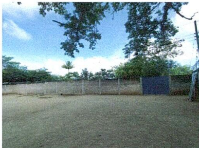
Foto1: Aplicación de cernido en muro perimetral
