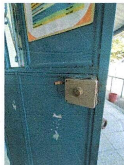
Foto 6: Sustitución de chapa Yale en puerta
