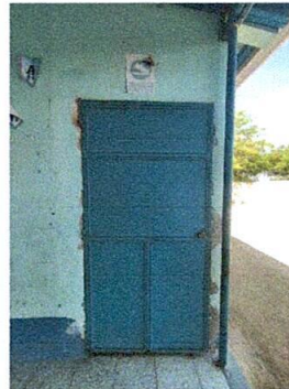
Foto 2: Mantenimiento a puertas de metal (Lijado, cambio de tubo, cepillado y aplicación de pintura) de 1,6 mts2 cada una.
