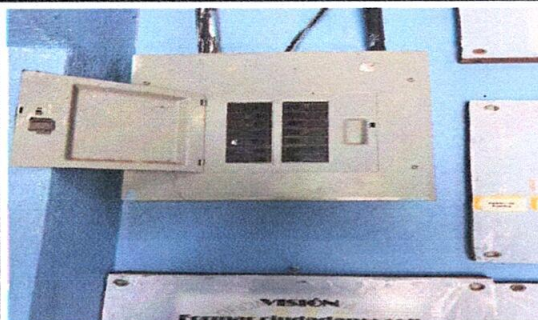
Foto 10: Sustitución de filipones en dirección
