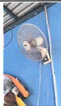
Foto 12: Sustitución de ventiladores de pared incluye instalación de tomacorriente y cableado eléctrico.
