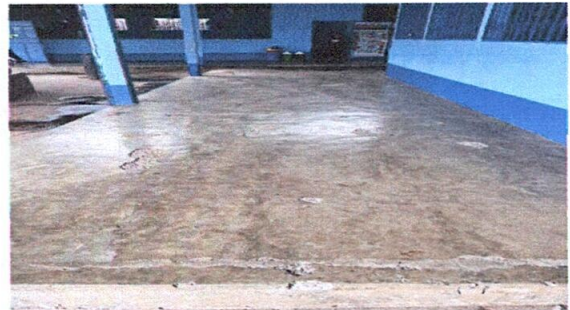
Foto 6: Corredor No.1 instalación de piso cerámico color mate
