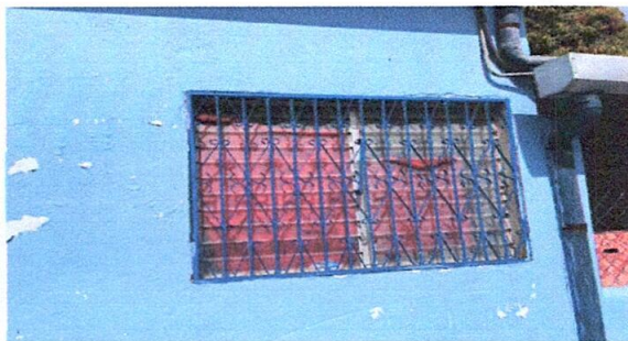
Foto 5: Direccion Ventana No. 2 sustitución de ventana por ventana PVC
