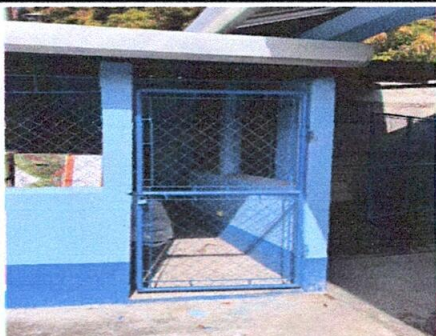
Foto 9: Cocina instalación de puerta
