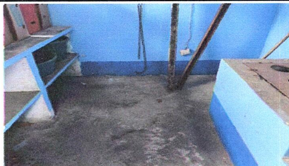
Foto 8: Cocina a la cual será instalado piso cerámico color mate.
