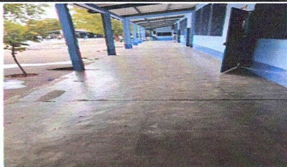
Foto 7: Corredor No.2 instalación de piso cerámico color mate.
