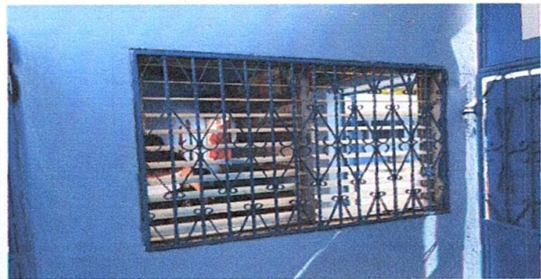
Foto 4: Direccion Ventana No.1 sustitución de ventana por ventana PVC.
