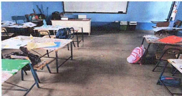
Foto 3: Aula No.3 a la cual será instalado piso cerámico color mate.
