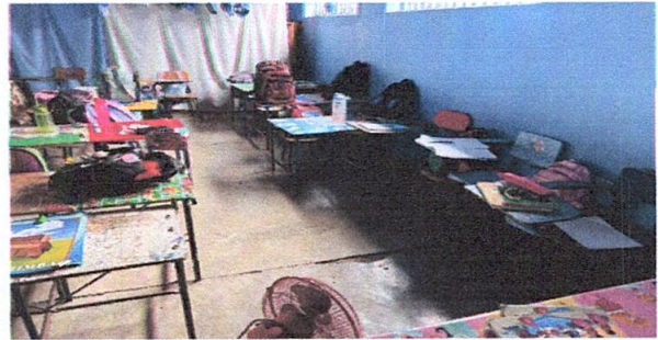
Foto 2: Aula No. 2 a la cual será instalado piso cerámico color mate.
