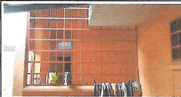
Foto 7: Instalación de Ventana PVC en Cocina
