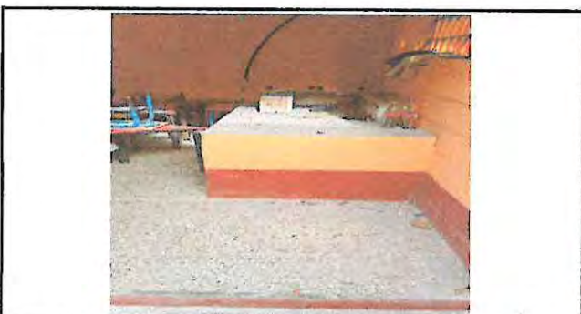
Foto 3: Sustitución de Estufa Rural Completa en Cocina
