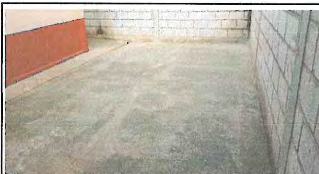
Foto 10: Sustitución de Planchas de Concreto en Patio
