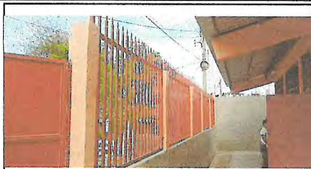
Foto 14: Instalación de Razor sobre Baranda de Metal en Muro Perimetral
