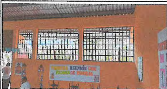
Foto 1: Instalación de Ventanas PVC en Aulas
