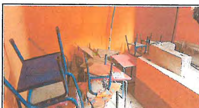
Foto 4: Edificación de Pila de Concreto y Block de 2 mts de largo por 1 metro de ancho e Instalación de Tubería de Aguas Servidas en Cocina
