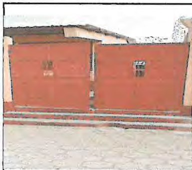
Foto 15: Mantenimiento y Ampliación de Portón de Entrada Principal (Medidas Actuales 2.50 mts por 2.44 mts / Medidas de como Quedará 3.33 mts por 2.44 mts.)
