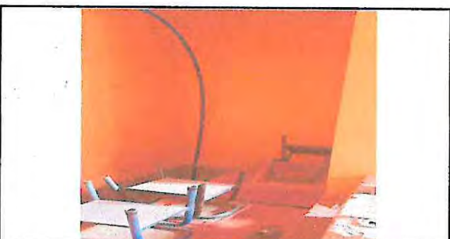
Foto 5: Edificación de Mueble de Concreto para polletón con Azulejo de 2.5 mts de largo por 0.80 mts de ancho en Cocina
