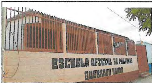
Foto 13: Instalación de Malla Mosquitera de Metal en Balcones de Muro Perimetral (Para evitar el que personas arrojen piedras para adentro de la Escuela)
