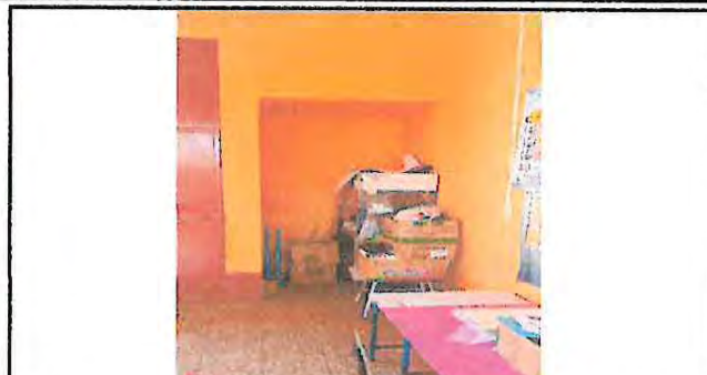
Foto 2: Instalación de Repisas de Concreto en Aulas
