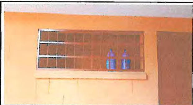
Foto 11: Instalación de Ventana PVC en Baños
