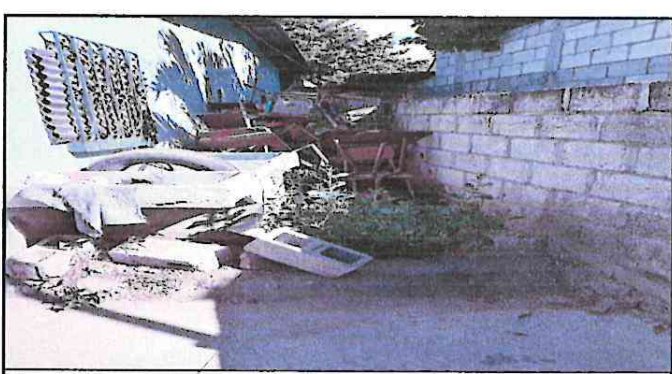
Foto 6: MURO QUE REQUIERE INCREMENTO DE ALTURA, REPELLO Y CERNIDO
