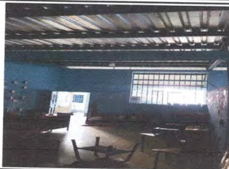
Foto 2: Instalación de Cielo Falso PVC en Aulas
