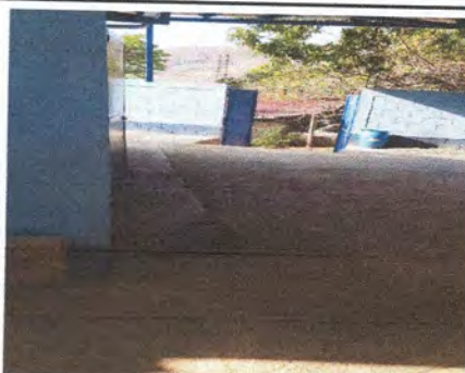
Foto 9: Instalación de Cuneta y Regilla en Patio (se Inunda en Invierno)
