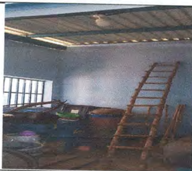
Foto 11: Instalación de Ventiladores en Cocina
