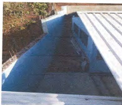
Foto 8: Instalación de Lámina y Estructura de Soporte en Escenario de Patio
