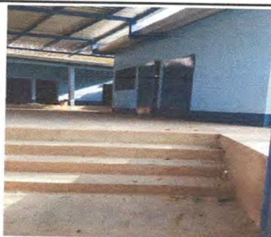
Foto 10: Instalación de Cuneta y Regilla en Patio (se Inunda en Invierno)
