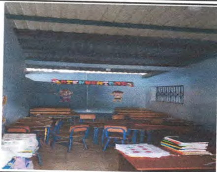
Foto1: Instalación de Cielo Falso PVC en Aulas
