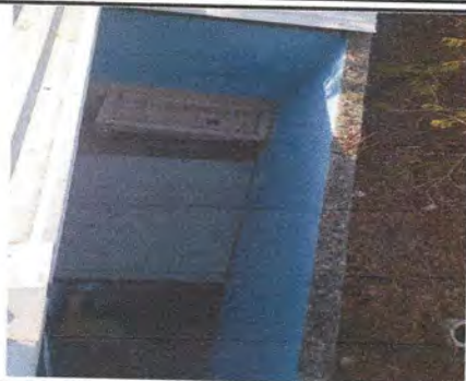
Foto 7: Instalación de Lámina y Estructura de Soporte en Escenario de Patio
