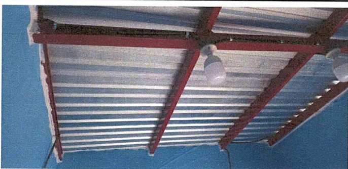
Foto 5: Instalación de cielo falso PVC en aulas.
