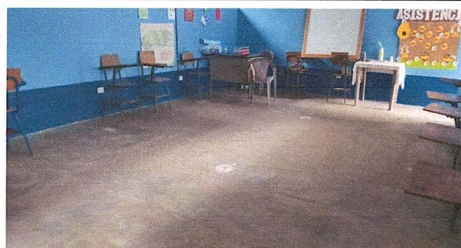
Foto 2: Instalación de piso cerámico mate en aulas.
