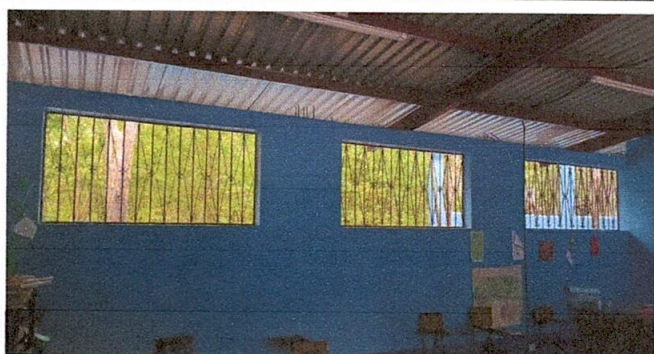
Foto 3: Instalación de ventanas PVC en aulas.
