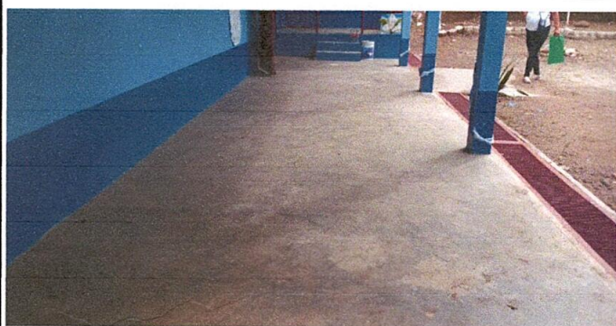
Foto 9: Instalación de piso cerámico mate en corredor.
