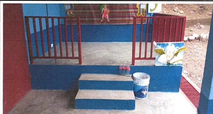
Foto 10: Instalación de piso cerámico mate en aulas.
