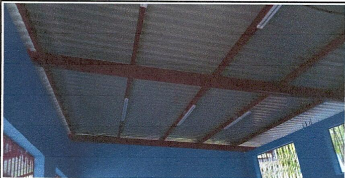
Foto 1: Instalación de cielo falso PVC en aulas.
