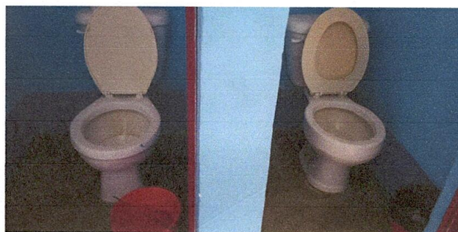
Foto 11: Sustitución de inodoros en baños.
