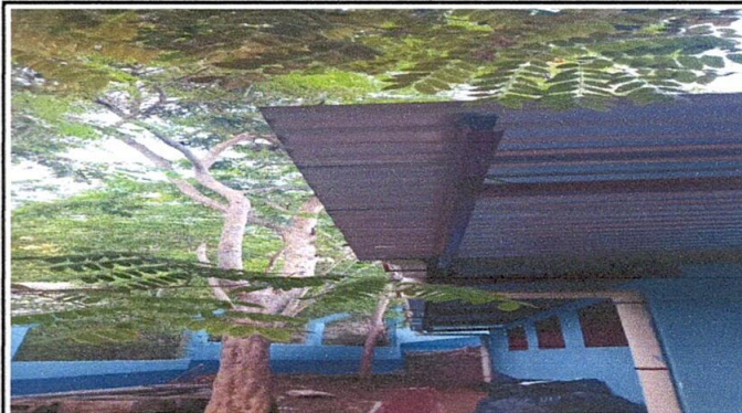
Foto 14: Instalación de canal de metal en baños.
