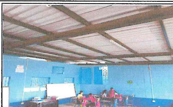
FOTO 2: Mantenimiento de estructura de soporte de metal en aula.
