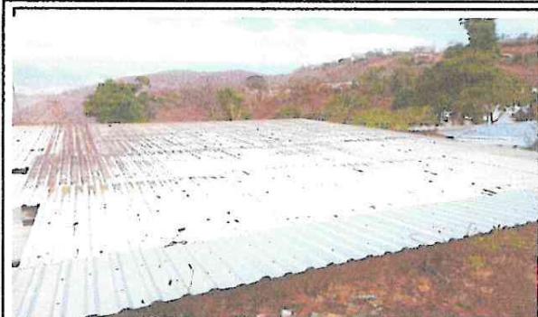
FOTO 1: Sustitución de lamina troquelada en aula.
