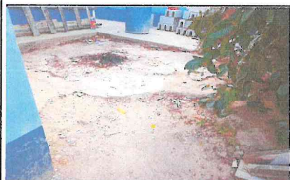
FOTO 3: Sustitución de planchas de concreto en patio.
