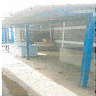
Foto 11: Circulación con Malla y Tubo Galvanizado en Cocina
