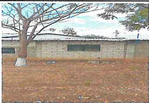
Foto 1: Sustitución de Lámina Troquelada en Aulas
