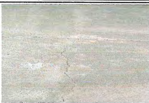
Foto 8: Sustitución de Piso de Concreto por Piso de Concreto Liso en Aulas
