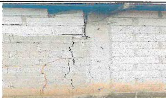
Foto 5: Demolición de Muros en Mal estado en Aulas
