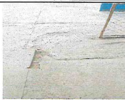
Foto 14: Sustitución de Planchas de Concreto en Patio
