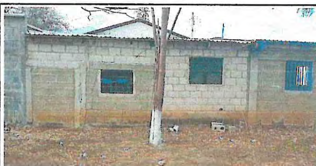
Foto 6: Demolición de Muros en Mal estado en Aulas
