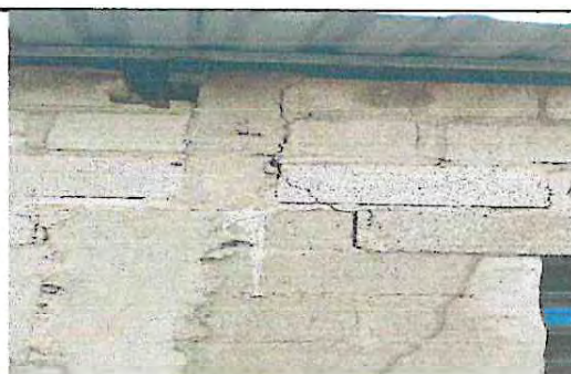
Foto 4: Demolición de Muros en Mal estado en Aulas
