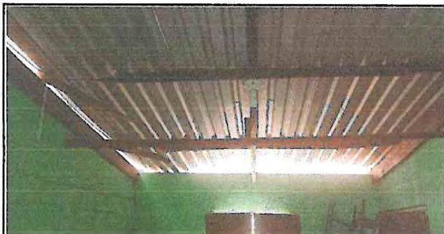
Foto 3: Sustitución de Estructura de Soporte de Madera por Estructura de Soporte de Metal en Aulas
