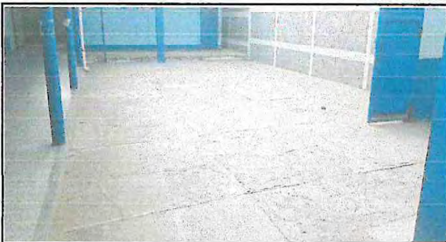
Foto 13: Sustitución de Planchas de Concreto en Patio
