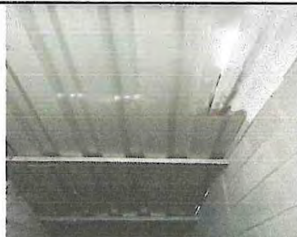
Foto 2: Sustitución de Lámina Troquelada en Aulas
