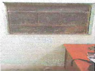
Foto 9: Sustitución de Ventana y Balcón de Metal de 1 metro por 1 metro en Aulas
