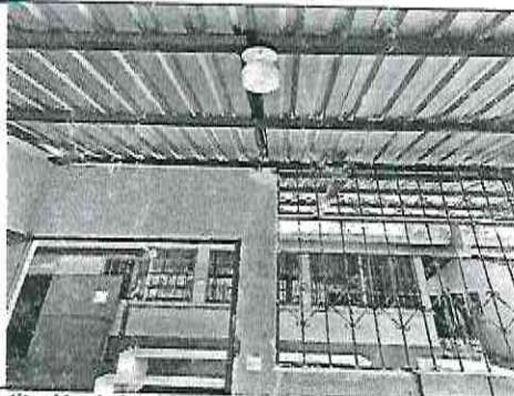
Foto 5: Sustitución de luminaria y sustitución de interruptor en Cocina
