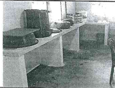
Foto 2: Instalación de mueble de Concreto para meson e instalación de azulejo en Cocina
