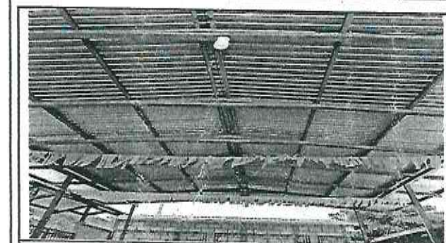
Foto 3: Instalación de luminaria en galera de cancha
