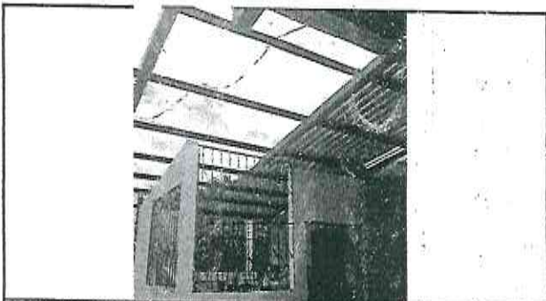
Foto 3: Sustitución por lámina troquelada
