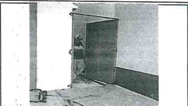
Foto 2: Sustitución de puerta de metal
