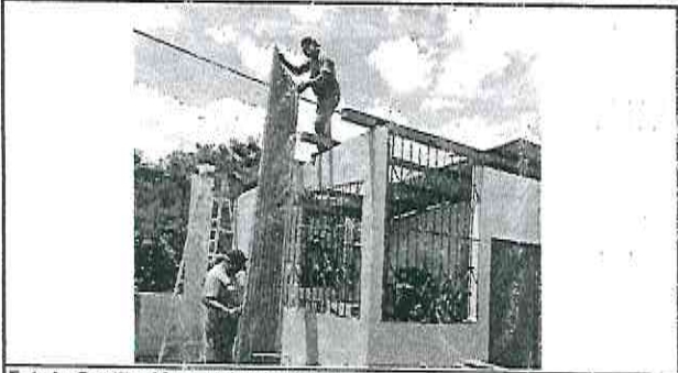
Foto1: Sustitución de Lámina ondulada
