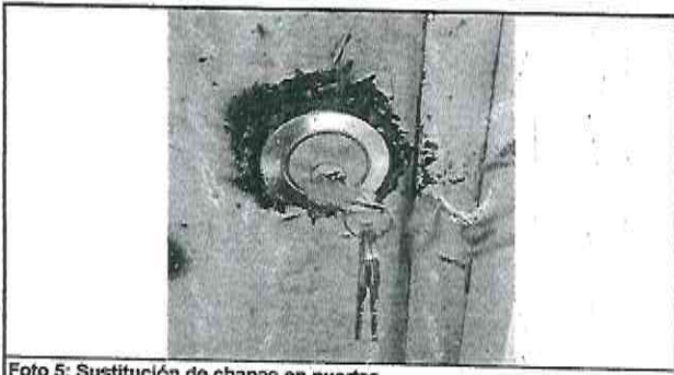
Foto 5: Sustitución de chapas en puertas
