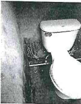
Foto 5: SUSTITUCIÓN DE RED DE DISTRIBUCIÓN DE AGUA EN BAÑOS.
