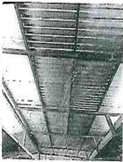
Foto 2: SUSTITUCIÓN DE ESTRUCTURA DE SOPORTE DE METAL, EN GALERA PATIO.
