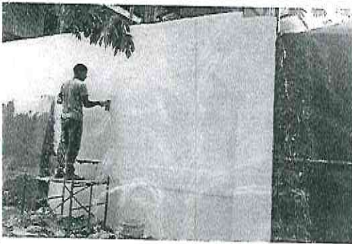
Foto 4: INSTALACIÓN DE REPELLOS Y CERNIDOS EN PARED FRONTAL DE LA ESCUELA.
