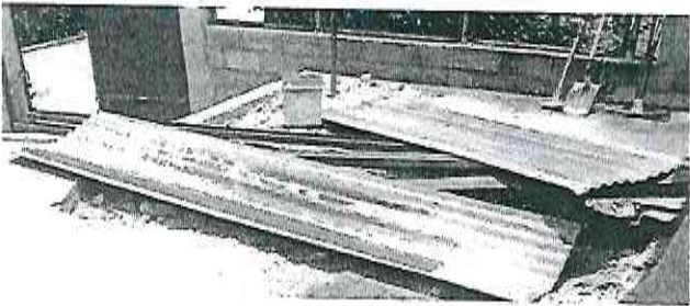
Foto 1: SUSTITUCIÓN DE LÁMINA ONDULADA POR LÁMINA TROQUELADA EN GALERA PATIO.
