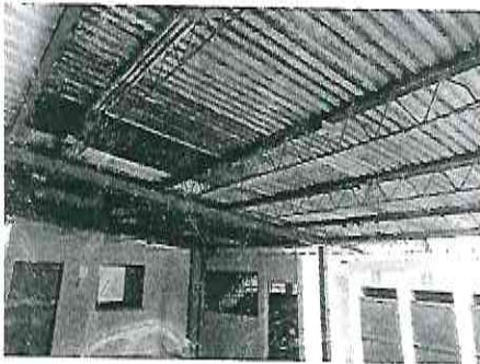
Foto 2: SUSTITUCIÓN DE ESTRUCTURA DE SOPORTE DE METAL, EN GALERA PATIO.
