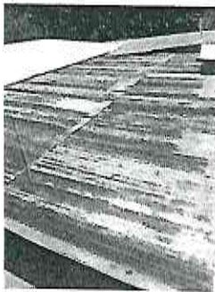
Foto1:SUSTITUCIÓN DE LÁMINA ONDULADA POR LÁMINA TROQUELADA EN GALERA PATIO.
