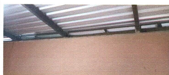
Foto 3: Entablar muros en aulas.
