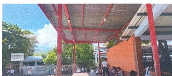
Foto 6: Sustitución de lámina y Mantenimiento preventivo y correctivo en estructura de soporte de metal.
