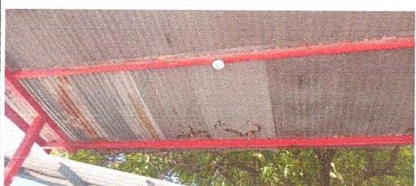
Foto 9: Electricidad en galera de patio.
