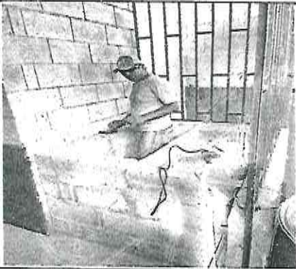
Foto 7: Instalación de pilas de Block y Concreto en baños.
