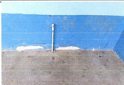
Foto 1: COCINA-INSTALACIÓN DE PILA DE 1 LAVADERO
