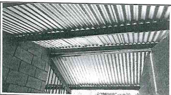
Foto 6: Sustitución de lámina ondulada por lámina troquelada calibre 26 aluzinc
