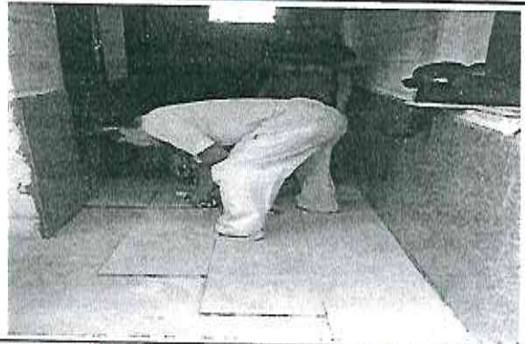
Foto 2: Sustrucción de Piso de concreto por piso cerámico mate
