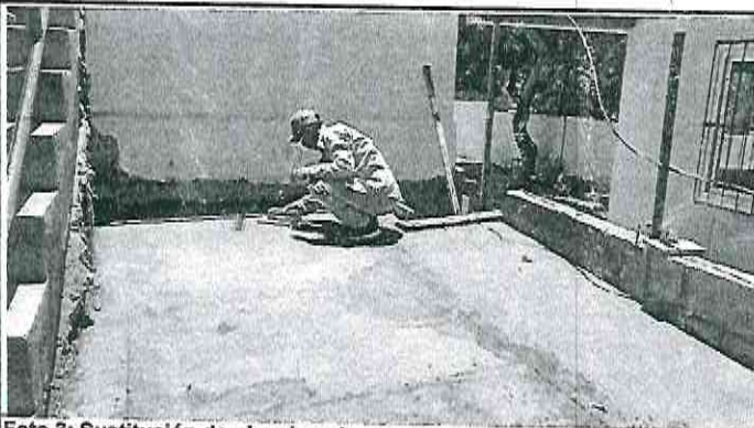
Foto 3: Sustitución de planchas de concreto
