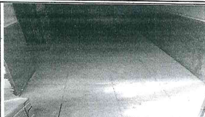
Foto 2: Sustrucción de Piso de concreto por piso cerámico mate
