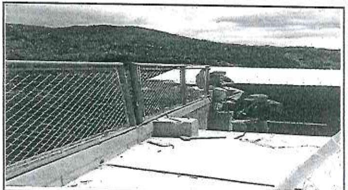
Foto 4: Sustitución de Baranda en área de peligro
