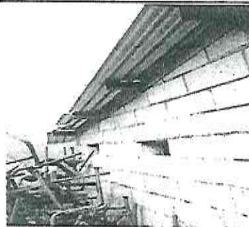
Foto 8: Sustitución de Lámina y Estructura de Soporte en Baños
