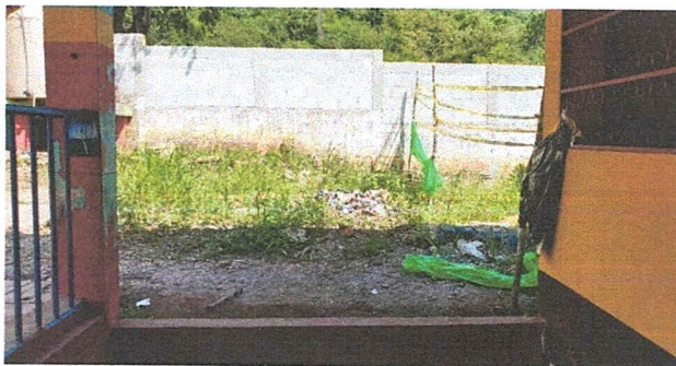
FOTO 11: INSTALACION DE PUERTA PARA DIVIDIR NIVEL PRIMARIO Y PRE PRIMARIO (2.40 ANCHO X 1.90 ALTO)
