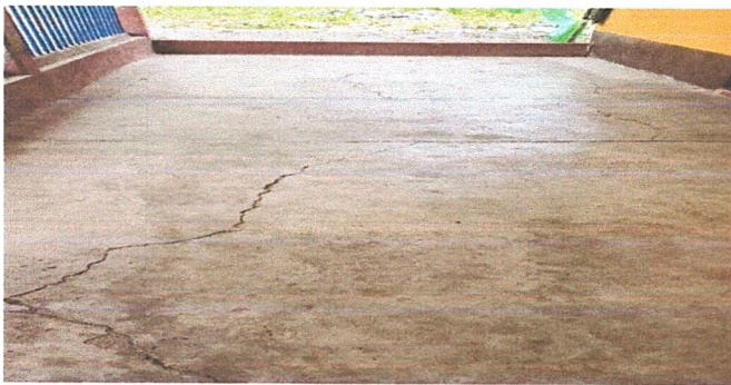
FOTO 15: DEMOLICIÓN DE LOSA DE CONCRETO
