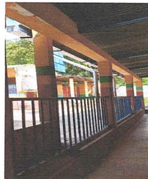
FOTO 12: SUSTITUCION DE BARRANDA PARA INSTALACION DE BALCON (2.33 ALTO X 3.40 ANCHO)
