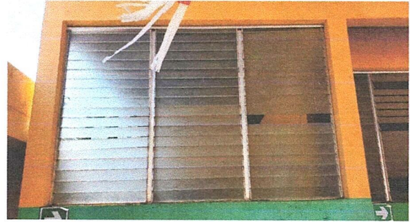
FOTO 14: SUSTITUCIÓN DE BARRANDA PARA INSTALACIÓN DE BALCON DE 2.33 ALTO X 3.34 ANCHO
