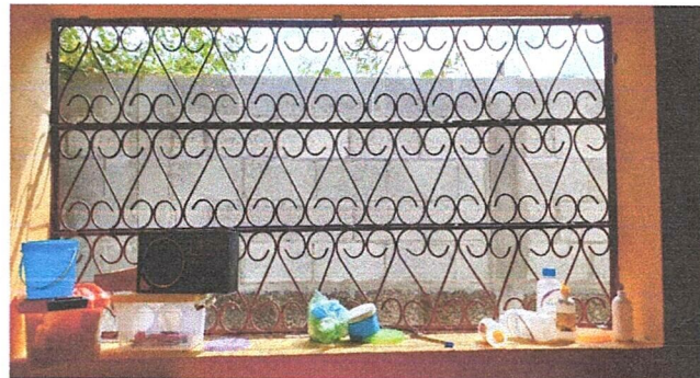
FOTO 2: SUMINISTRO E INSTALACION DE VENTA PVC DE (1.51 ALTO X 0.89 ANCHO)
