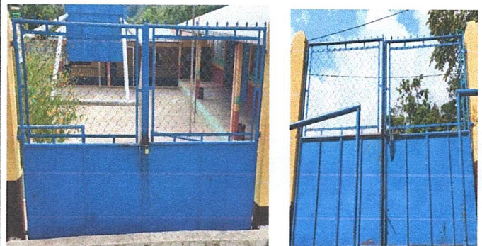
FOTO 10: SUSTITUCION E INSTALACION DE PORTON PRINCIPAL DE (4.20 ALTO X 5.9 ANCHO)
