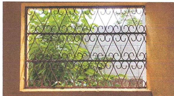
FOTO 4: SUMINISTRO E INSTALACIÓN DE VENTA PVC DE (0.73 ALTO X 0.89 ANCHO )
