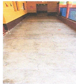
FOTO 16: FUNDICIÓN DE LOSA
