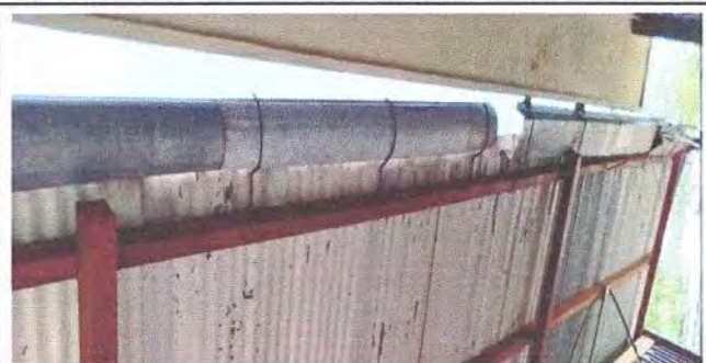
FOTO: SUSTITUCION DE CANAL DE METAL + BAJADA DE AGUA PLUVIAL
