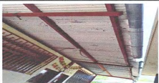
FOTO: INSTALACION DE CIELO FALSO EN AULAS + INSTALACION DE LUMINARIAS
