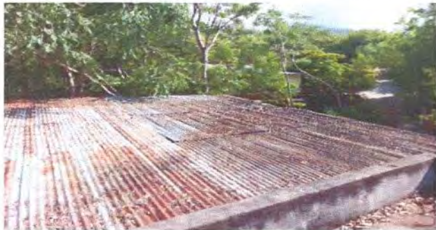
FOTO: SUSTITUCION DE LAMINA POR LAMINA TROQUELADA ALUZING CALIBRE 26
