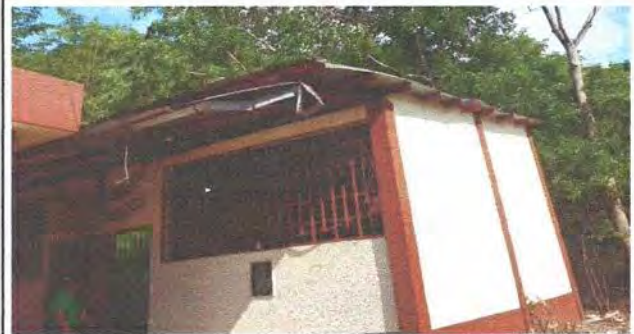
FOTO: INSTALACION DE CANAL DE METAL
