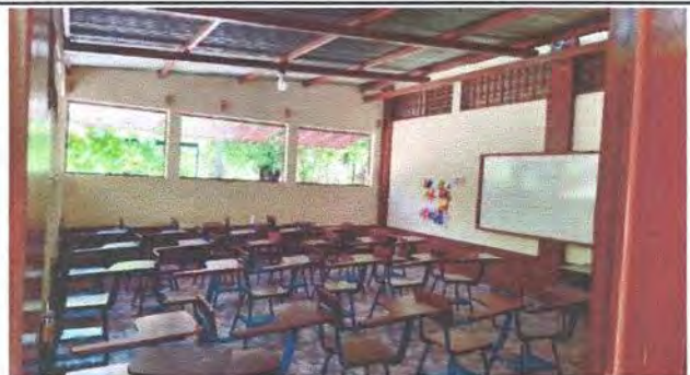
FOTO: INSTALACION DE CIELO FALSO + INSTALACION DE PLAFONERAS Y FOCOS
