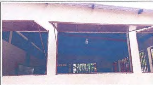
FOTO: FABRICACIÓN E INSTALACIÓN DE VENTANAS PVC E INSTALACIÓN DE BALCONES DE METAL
