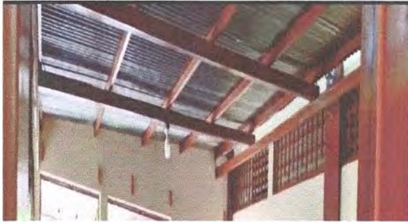
FOTO: MANTENIMIENTO A ESTRUCTURA DE METAL (CEPILLADO, LIJADO Y PINTURA)
