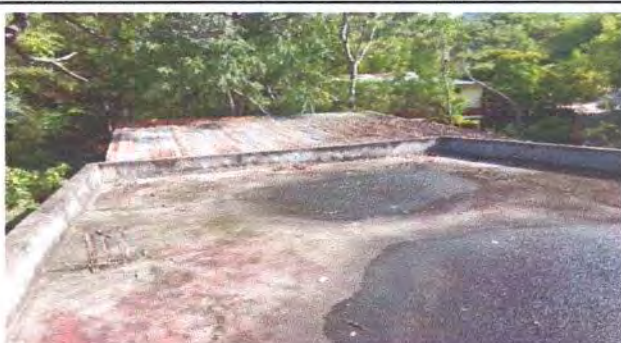
FOTO: LIMPIEZA DE LOSA (YA SE CUENTAN CON BAJADAS DE AGUA PLUVIAL) PARA SU POSTERIOR IMPERMEABILIZACION
