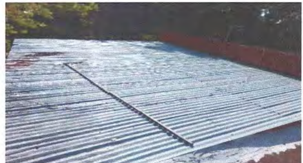
FOTO: SUSTITUCION DE LAMINA POR LAMINA TROQUELADA ALUZING CALIBRE 26
