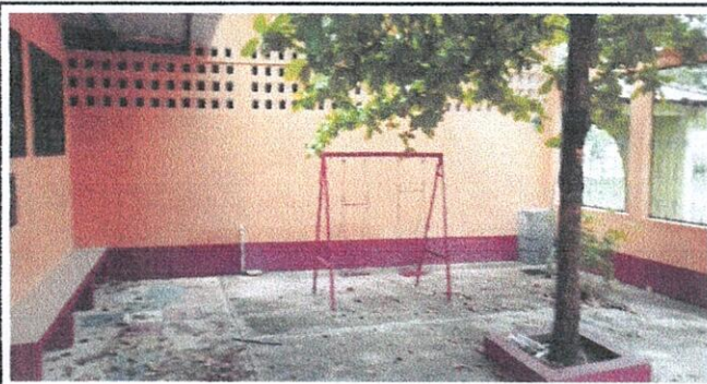
Foto 1: Pintura en Muros en Aulas
