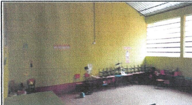
Foto 2: Pintura en Muros en Aulas
