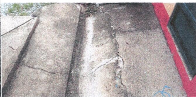
Foto 9: Sustitución de cuneta de concreto en patio.
