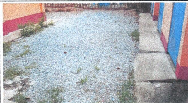
Foto 8: Plancha de concreto en patio.
