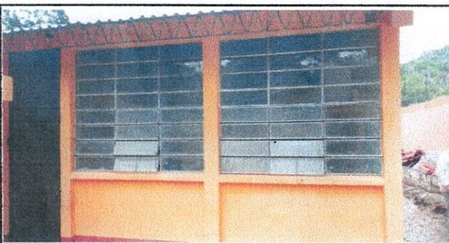
Foto 3: Reconstrucción de Balcones de Metal e Instalación de Ventanas PVC en Aulas
