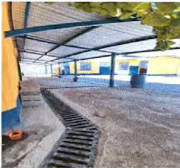
FOTO 11: SUSTITUCIÓN DE PLANCHA DE CONCRETO
