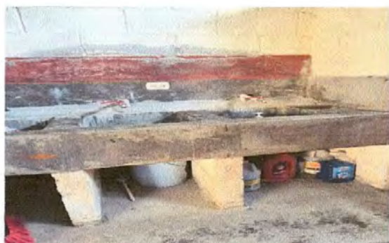
FOTO 3: SUMINISTRO E INSTALACIÓN DE AZULEJO
