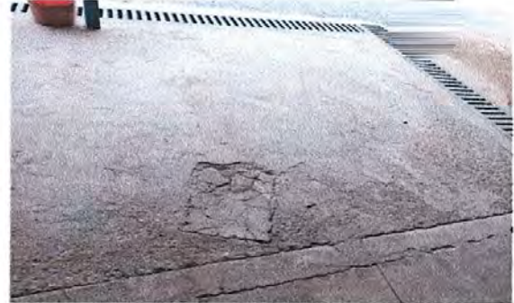
FOTO 10: SUSTITUCIÓN DE PLANCHAS DE CONCRETO
