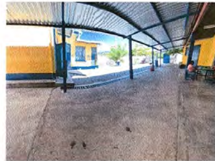
FOTO 12: SUSTITUCIÓN DE PLANCHA DE CONCRETO
