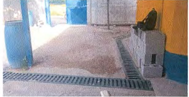
FOTO 8: SUSTITUCIÓN DE PLANCHAS DE CONCRETO
