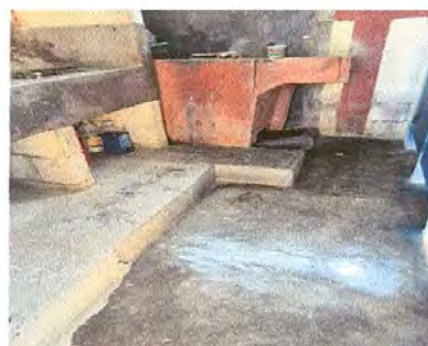
FOTO 4: SUMINISTRO E INSTALACIÓN DE AZULEJO
