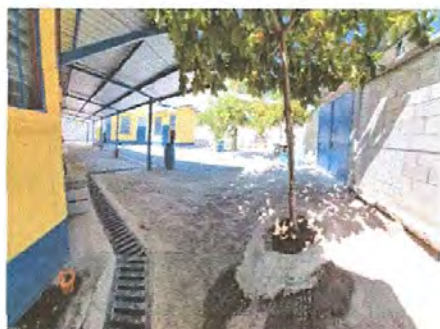
FOTO 15: SUSTITUCIÓN DE PLANCHA DE CONCRETO
