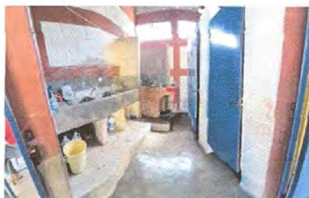
FOTO 17: SUMINISTRO E INSTALACIÓN DE PISO CERAMICO
