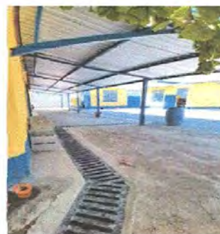
FOTO 16: SUSTITUCIÓN DE PLANCHA DE CONCRETO
