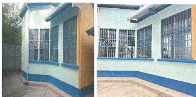
FOTO 1: PINTURA DE MUROS INTERIORES Y EXTERIORES
