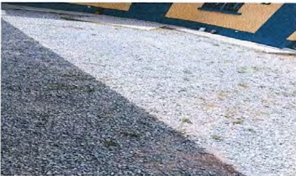
FOTO 9: SUSTITUCIÓN DE PLANCHAS DE CONCRETO
