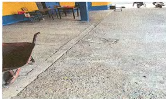
FOTO 6: SUSTITUCIÓN DE PLANCHAS DE CONCRETO
