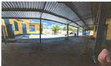
FOTO 13: SUSTITUCIÓN DE PLANCHA DE CONCRETO
