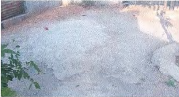
FOTO 7: SUSTITUCIÓN DE PLANCHAS DE CONCRETO
