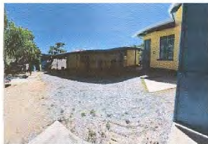
FOTO 14: SUSTITUCIÓN DE PLANCHA DE CONCRETO
