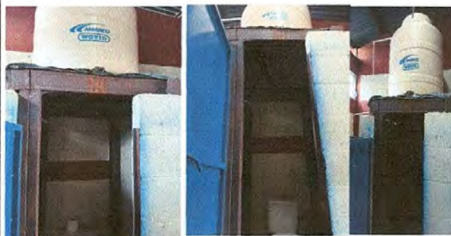
FOTO 2: SUSTITUCIÓN DE BASE DE METAL DE 3 MTS. DE ALTO PARA INSTALACIÓN DE SISTEMA DE AGUA
