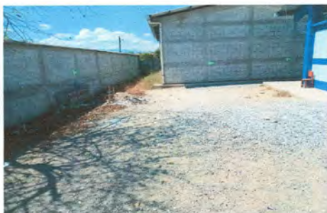
FOTO 7: Sustrución de planchas de concreto en patio.
