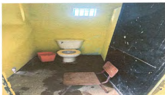
FOTO 5: Sustitución de inodoros en baños.
