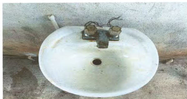
FOTO 6: Sustitución de lavamanos por base de block para lavamos de cuatro chorros en baños.
