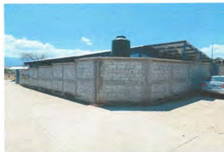
FOTO 8: Instalación de razor galvanizado en muro perimetral.FOTO 8: Instalación de razor galvanizado en muro perimetral.
