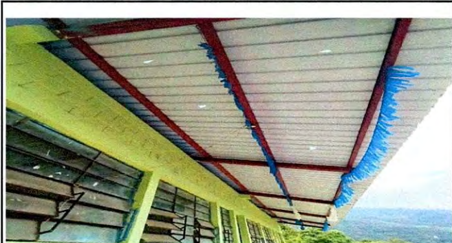
Foto 16: SUSTITUCIÓN DE LÁMINA, POR LÁMINA TROQUELADA ALUZINC CALIBRE 26
