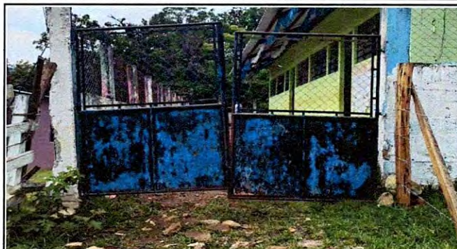
Foto 2: SUSTITUCIÓN E INSTALACIÓN DE PORTÓN DE METAL DE 3.10 MTS X 3 MTS.
