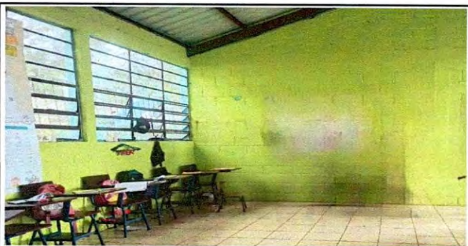
Foto 5: PINTURA INTERIOR Y EXTERIOR (Aula 1)
