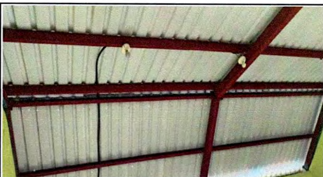
Foto 3: SUSTITUCIÓN DE CABLEADO ELÉCTRICO EN AULA 1
