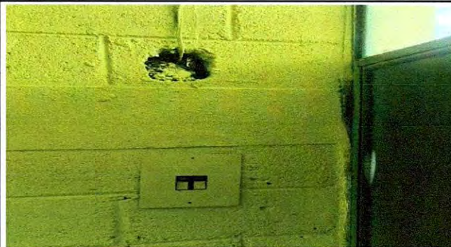
Foto 15: SUSTITUCIÓN DE TABLERO DE FLIPONES DE DOS CIRCUITOS
