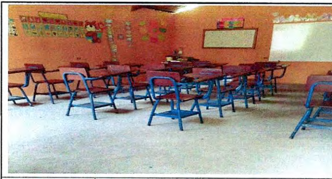
Foto 11: COLOCACIÓN DE PISO CERÁMICO (Aula 3)
