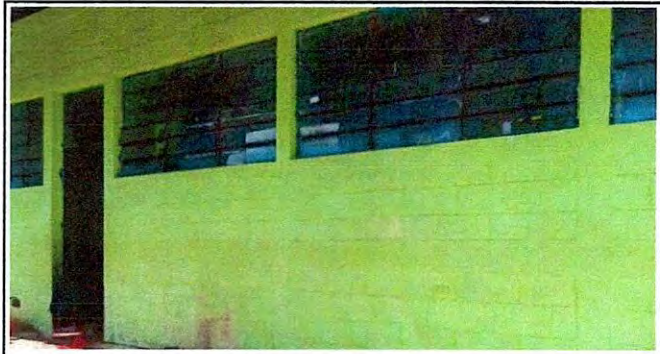
Foto 8: PINTURA INTERIOR Y EXTERIOR (Aula 2)
