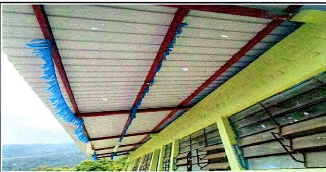
Foto 17: INSTALACIÓN DE COSTANERAS CALIBRE 16.
