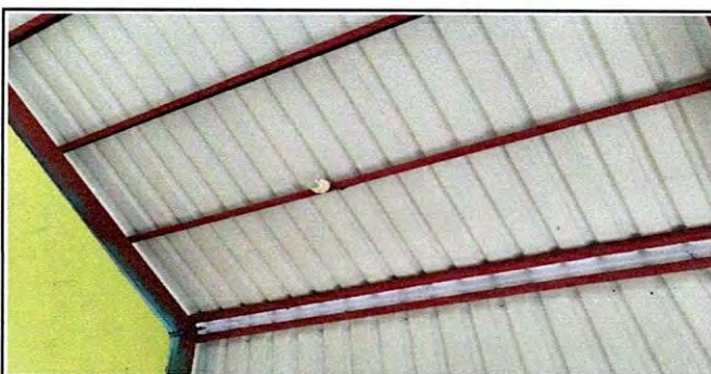
Foto 6: SUSTITUCIÓN DE CABLEADO ELÉCTRICO EN AULA 2
