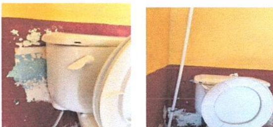
FOTO 6: SUSTITUCIÓN E INSTALACIÓN DE KIT DE ACCESORIOS PARA INODORO
