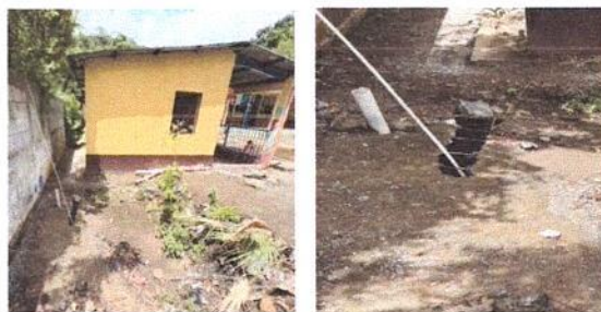
FOTO 2: LEVANTADA DE HILADAS DE BLOCK
