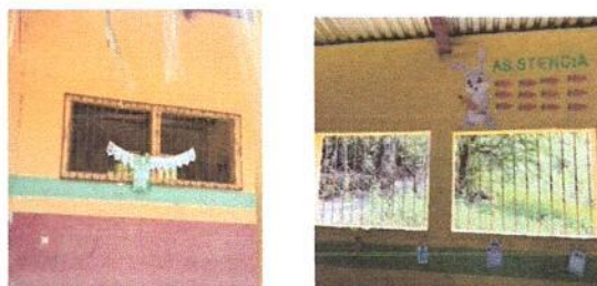
FOTO 4: SUMINISTRO E INSTALACIÓN DE VENTANAS PVC DE (1.59 X 0.86)
