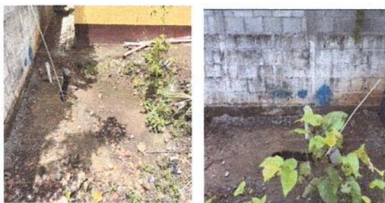
INSTALACION DE PLANCHA DE CONCRETO (INCLUYE RESPIRADERO)
