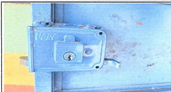
FOTO 7: SUSTITUCION DE CHAPA EN PUERTAS
