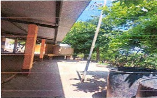
Foto 29: Modulo "3" Corredores: Nivelación de loza de concreto
