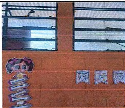
Foto 3: Aula 1: Compra e Instalación de Ventilador de pared (2), Instalación de apagadores.
