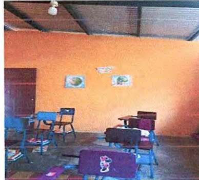
Foto 16: Aula 4: Compra e Instalación de Ventilador de pared (2), Instalación de toma corriente.
