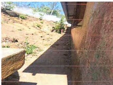
Foto 31: Modulo "4" Muro: Sustitución de cuneta de concreto.
