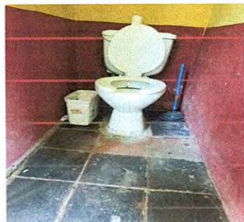
Foto 23: Modulo 2 "Baños" Sustitución e instalación de baños (4)
