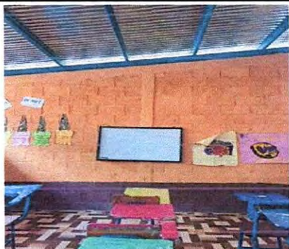
Foto 19: Aula 5: Compra e Instalación de ventilador de pared (2), Instalación de toma corrientes.
