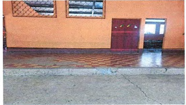
Foto 28: Modulo "3" Corredores: Colocación de piso ceramico de exterior antideslizante.
