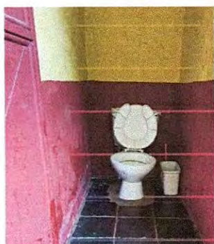
Foto 21: Modulo 2 "Baños" Sustitución e Instalación de Baño (2)
