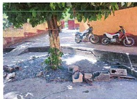
Foto 4: Modulo 1: Sustitución e instalación de plancha de concreto
