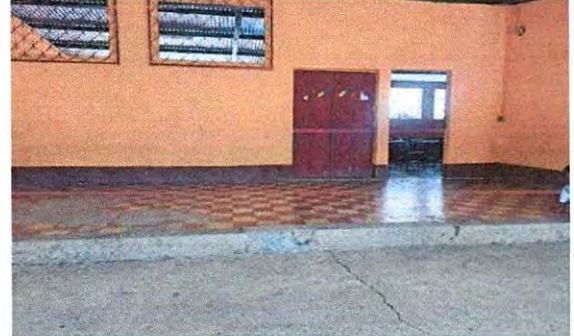
Foto 26: Modulo "3" Corredores, Demolición de Loza de concreto
