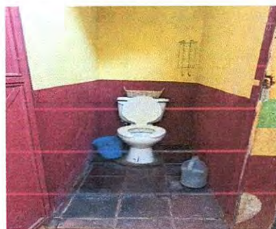
Foto 22: Modulo 2 "Baños" Sustitución e instalación de baños (3)
