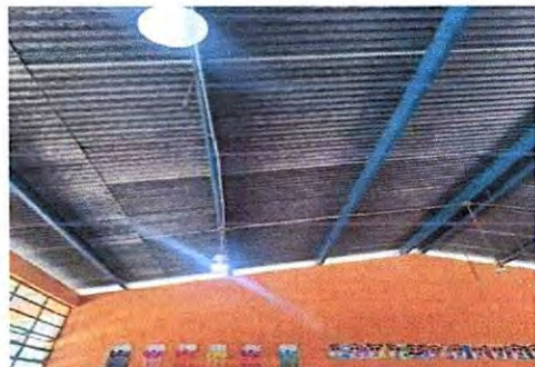
Foto 1: Aula 1: Retiro de cable electrico existente, colocación de cable calibre 10, Flaponeras, Bombillas de 40 amperios.
