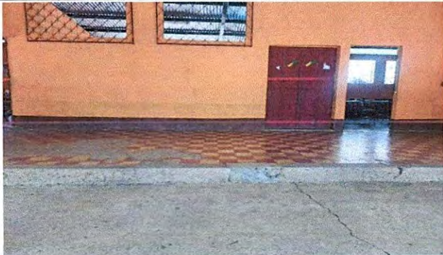
Foto 27: Modulo "3" corredores: Reparación de loza de concreto
