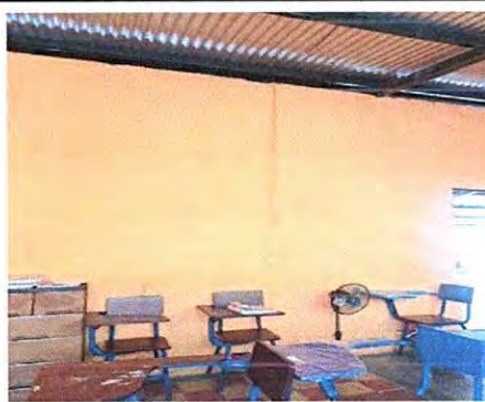
Foto 14: Aula 4: Retiro de cable electrico existente, colocación de cable calibre 10, Flaponeras, Bombillas de 40 amperios, Instalación de apagadores dobles.
