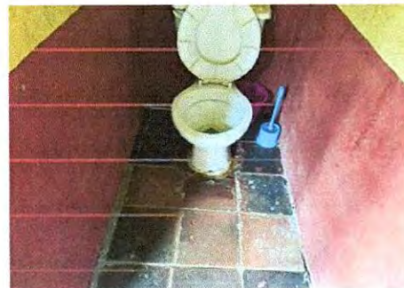
Foto 20: Modulo 2 "Baños": Sustitución e Instalación de Baño (1)
