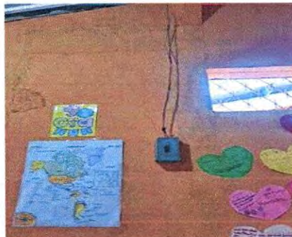
Foto 8: Aula 2: Sustitución e instalación de flipone (40 AMPERIOS, 2 CIRCUITOS)
