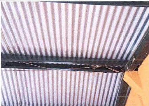
Foto 7: Aula 2: Retiro de cable electrico existente, colocación de cable calibre 10, Flaponeras, Bombillas de 40 amperios.
