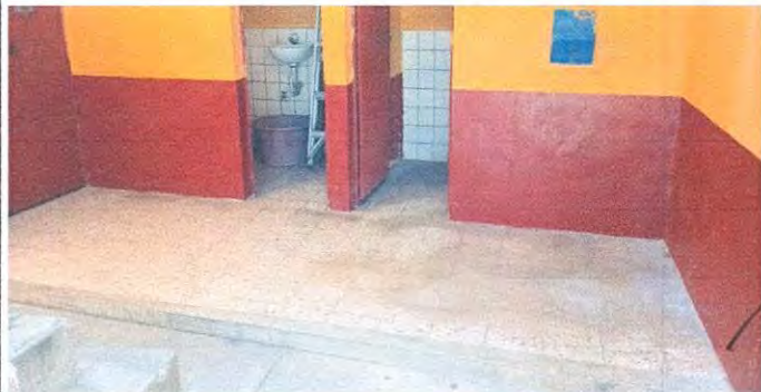
Foto 13: Sustitución de Piso de Granito por Piso Mate en Baños
