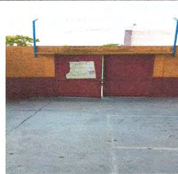
Foto 12: Sustitución de Portón de Metal en Entrada Principal
