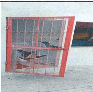
Foto 9: Sustitución de Malla Mosquitera en Cocina
