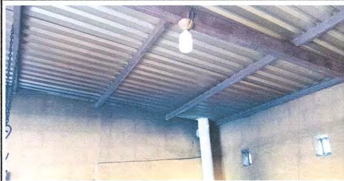
Foto 7: Sustitución de Lámina y Soporte de Metal en Cocina
