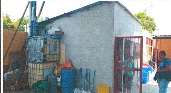
Foto 8: Pintura en Muros Interiores y Exteriores en Cocina
