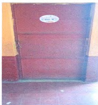
Foto 5: Sustitución de Chapas en Puertas de Aulas
