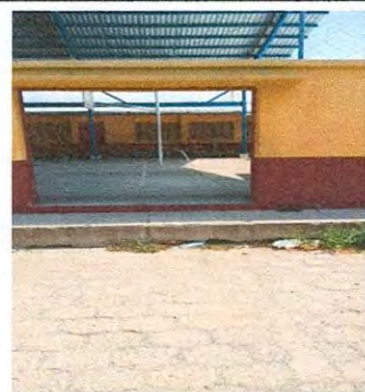
Foto 11: Instalación de Rampa en Entrada Principal
