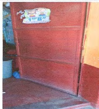
Foto 6: Mantenimiento de Puertas en Aulas
