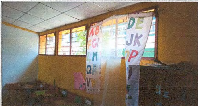
Foto 1: Desmontaje, Mantenimiento y Reinstalación de Balcones en Aulas
