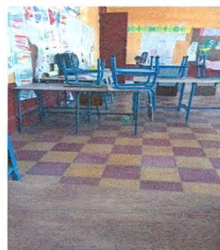
Foto 4: Instalación de Piso Cerámico Mate en Aulas
