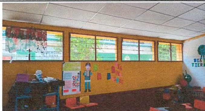
Foto 2: Instalación de Ventanas PVC en Aulas
