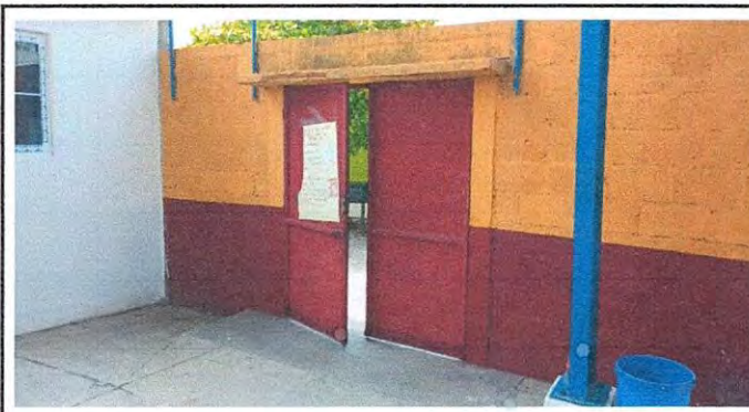
Foto 10: Demolición de Muros en Entrada Principal
