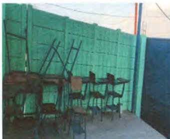
Foto 5: Reparación muro Perimetral de soleras intermedias y columnas
