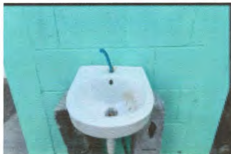
Foto 12: SUSTITUCIÓN DE LAVAMANOS CON BASE DE BLOQUE PARA LAVAMANOS DE DOS CHORROS
