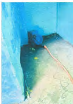
Foto 13: SUSTITUCIÓN DE BOMBA
