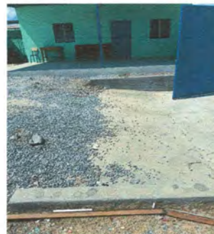
Foto 10: REPARACIÓN DE PLANCHA DE CONCRETO DE PATIO
