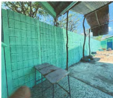
Foto 3: Instalación de Razor Galvanizado Instalación de Razor Galvanizado
