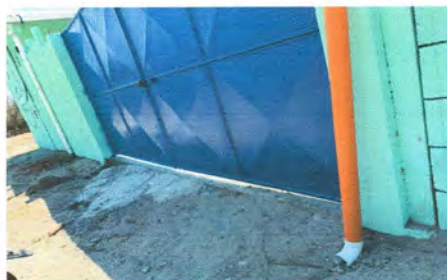
Foto 8: REPARACIÓN DE BANQUETA DE CONCRETO
