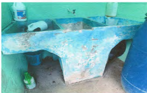
Foto 11: SUSTITUCIÓN DE PILA DE CEMENTO DE DOS LAVADEROS
