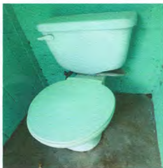
Foto 9: SUSTITUCIÓN DE INODORO
