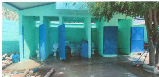
FOTO 14: SUSTITUCIÓN DE PISO DE TORTA DE CONCRETO POR PISO CÉRAMICO EN 4 BAÑOS (cerámico en pared) AREA DE PILA
