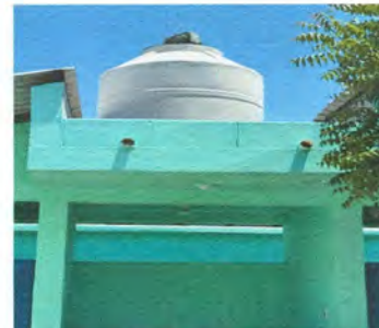
Foto 6: Sustitución de depósito de agua 1,700 litros Sustitución de depósito de agua 1,700 litros
