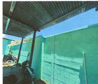
Foto 4: Instalación de Razor Galvanizado Instalación de Razor Galvanizado
