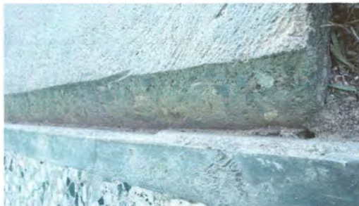
Foto 7: REPARACIÓN DE CUNETA DE CONCRETO Y PARRILLA DE AGUA PLUVIALES
