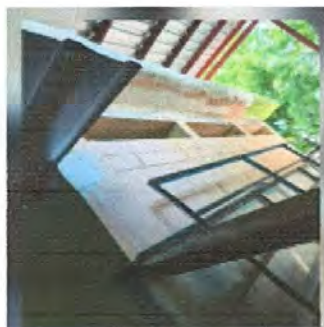
FOTO 3: Instalación de canal de metal.
