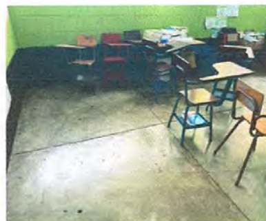
FOTO 2: Instalación de piso de concreto.
