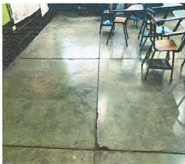
FOTO 1: Demolición y retiro de piso de concreto en mal estado.
