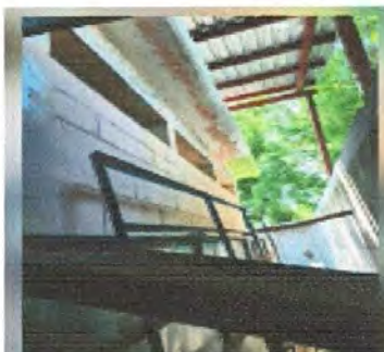
FOTO 4: Instalación de bajadas de agua pluvial.
