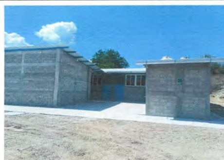
FOTO 6: Instalación de lamina troquelada calibre 26 Aluzinc. Instalación de estructura de soporte de metal.
