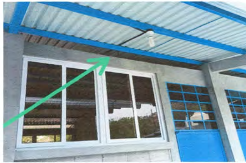
FOTO: 2 INSTALACIÓN DE BALCONES
