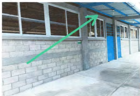
FOTO: 1 INSTALACIÓN DE BALCONES
