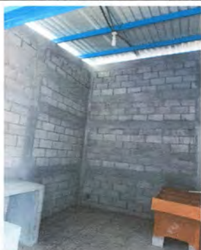
FOTO 3: Pintura en muros interiores y exteriores.
