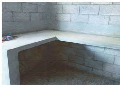
FOTO 4: Pintura en muros interiores y exteriores.
