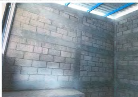
FOTO 5: Pintura en muros interiores y exteriores.
