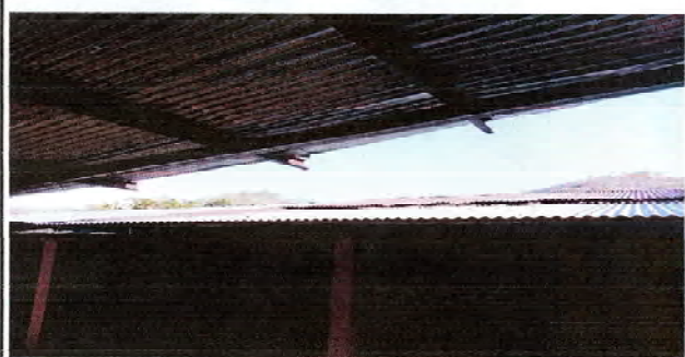
Foto 3: Sustitución de canal metalico
