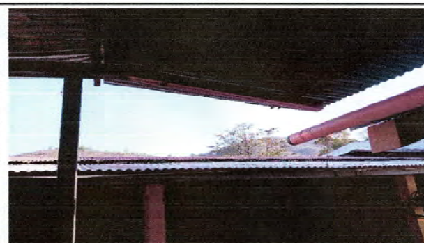
Foto 2: Sustitución de lamina por lamina troquelada calibre 26
