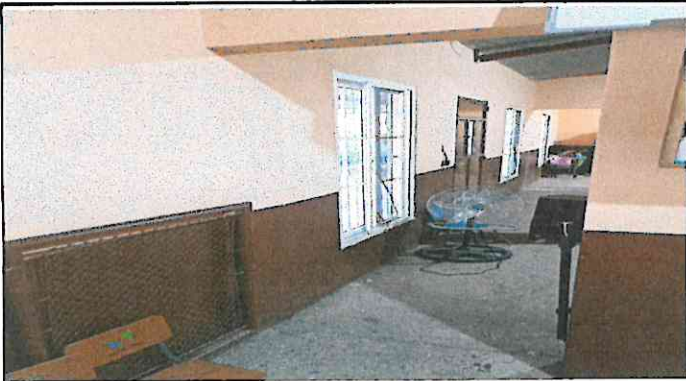
SUMINISTRO E INSTALACION DE PINTURA DE BUENA CALIDAD EN MUROS INTERIORES DE AULAS
