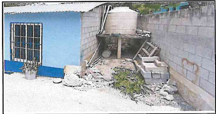
SUMINISTRO E INSTALACION DE TORTA DE CEMENTO CON ACABADO RUSTICO EN AREA DONDE ESTA EL ROTOPLAS (INCLUYE NIVELACION), SUMINISTRO E INSTALACION DE REPELLO Y CERNIDO EN PAREDES
