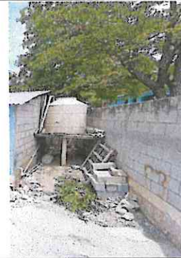
SUMINISTRO E INSTALACION DE PINTURA DE BUENA CALIDAD EN MUROS DONDE ESTA EL ROTOPLAS
