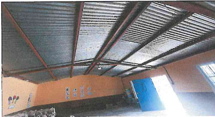
SUSTITUCION DE CABLEADO ELECTRICO EN AULAS
