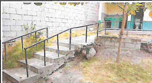
Foto 16: Sustitución de Baranda de Metal en Baños
