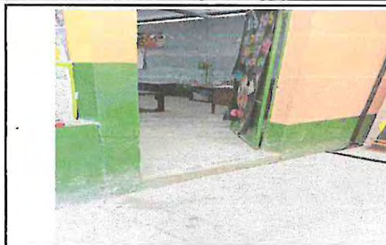
Foto 8: Instalación de Baranda de Metal de 1.12 mts de largo por 0.75 de alto en Aulas (Para Evitar el movimiento interno de los niños)
