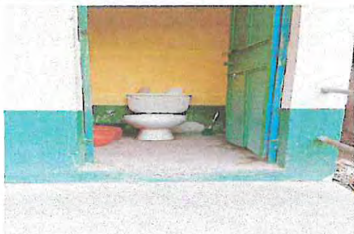
Foto 15: Sustitución de Inodoros en Baños
