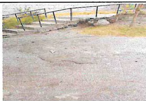
Foto 12: Sustitución de Planchas de Concreto en Patio
