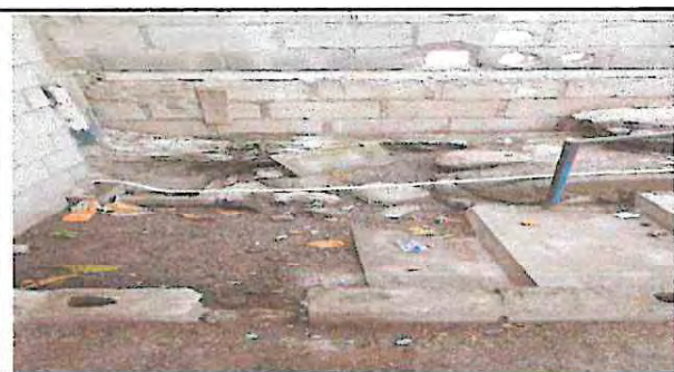
Foto 17: Sustitución de Planchas de Concreto en Patio
