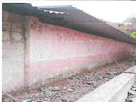
Foto 4: Sustitución de Cernidos en Muro en Aulas (Se votará el existente en Mal Estado)
