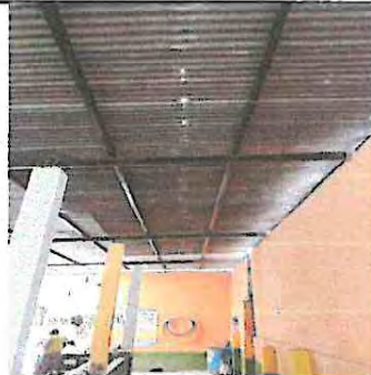
Foto 2: Sustitución de Lámina Ondulada por Lámina Ondulada calibre 26 en Aulas
