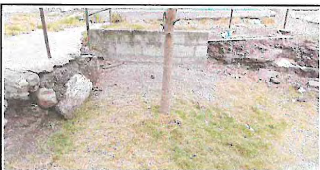
Foto 11: Sustitución de Muro de Block en Mal Estado en Baños
