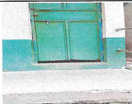
Foto 14: Mantenimiento de Puertas en Baños
