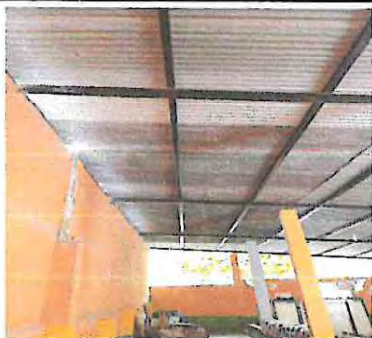
Foto 1: Sustitución de Lámina Ondulada por Lámina Ondulada calibre 26
