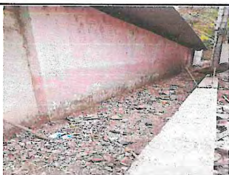
Foto 3: Impermeabilización de Muro (se Escarbará para tratar Muro) en Aulas
