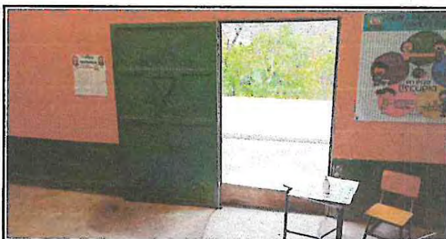
Foto 6: Sustitución de Puerta e Instalación de Contra Puerta en Aulas ( Se Instalará Contra Puerta para así tener Ventilación)
