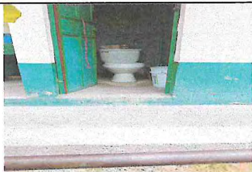
Foto 13: Instalación de Piso Cerámico Mate en Baños
