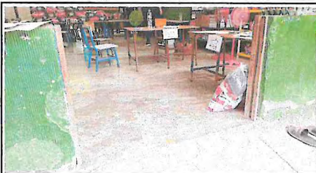
Foto 7: Instalación de Baranda de Metal de 1.12 mts de largo por 0.75 de alto en Aulas (Para Evitar el movimiento interno de los niños)
