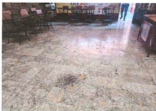
Foto 23: Sustitucion de Piso de granito por piso ceramico
