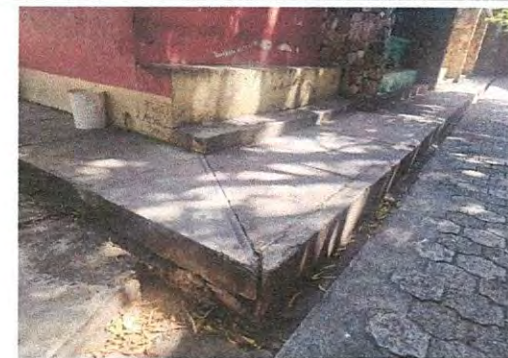
Foto 28: Sustrucción de banquetas
