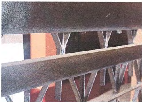
Foto 13: Sustitución de Ventanas de Paleta a PVC
