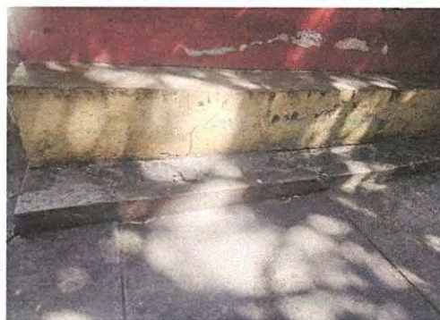
Foto 27: Sustrucción de banquetas
