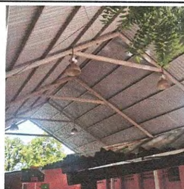
Foto 4: Sustitución de Plafoneras con sus focos
