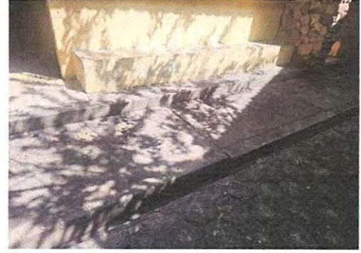
Foto 26: Sustrucción de banquetas
