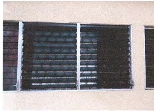
Foto 14: Sustitución de Ventanas de Paleta a PVC
