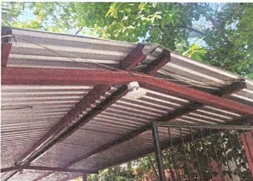
Foto 33: Sustrucción de cableado y colocacion de fexitubo
