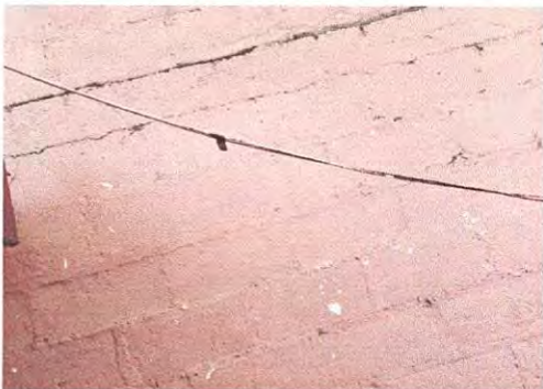
Foto 35: Sustrucción de cableado y colocacion de fexitubo
