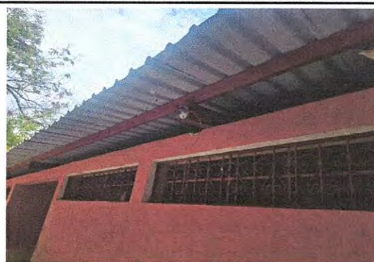
Foto 12: Sustitución de Ventanas de Paleta a PVC
