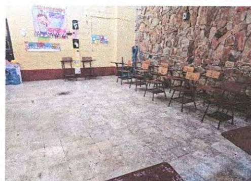
Foto 24: Sustitucion de Piso de granito por piso ceramico
