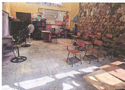
Foto 21: Sustitucion de Piso de granito por piso ceramico
