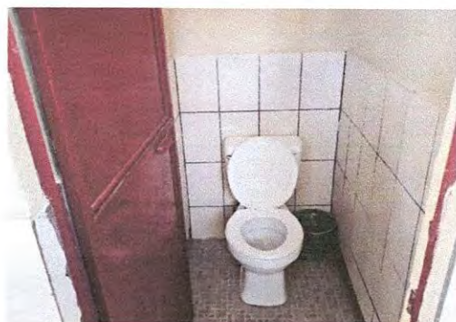
Foto 17: Sustitución de 10 kit de Sanitarios
