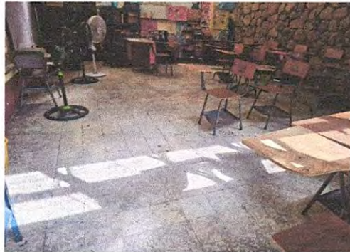
Foto 20: Sustitucion de Piso de granito por piso ceramico
