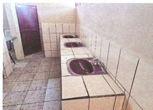
Foto 16: Sustitución de 6 kit de lavamanos
