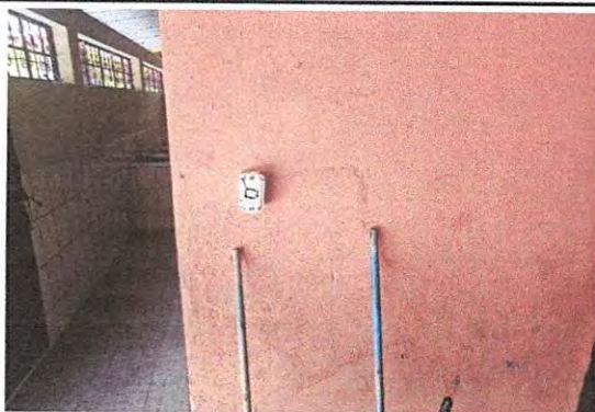
Foto 5: Reparación de Cableado eléctrico
