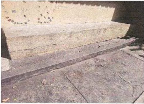
Foto 25: Sustrucción de banquetas
