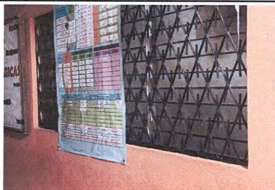
Foto 11: Sustitución de Ventanas de Paleta a PVC
