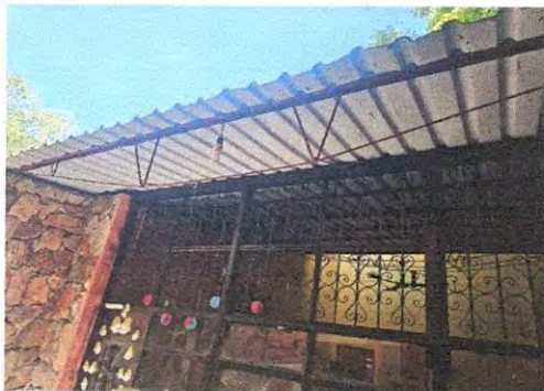
Foto 1: Reparación de Cableado eléctrico
