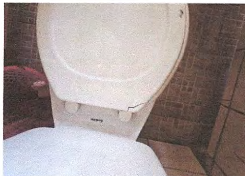
Foto 2: Sustitución de 10 kit de Sanitarios
