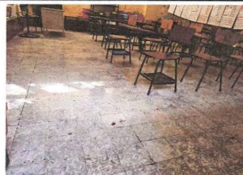
Foto 22: Sustitucion de Piso de granito por piso ceramico
