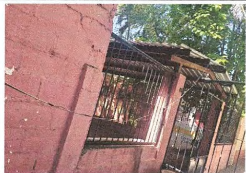
Foto 34: Sustrucción de cableado y colocacion de fexitubo
