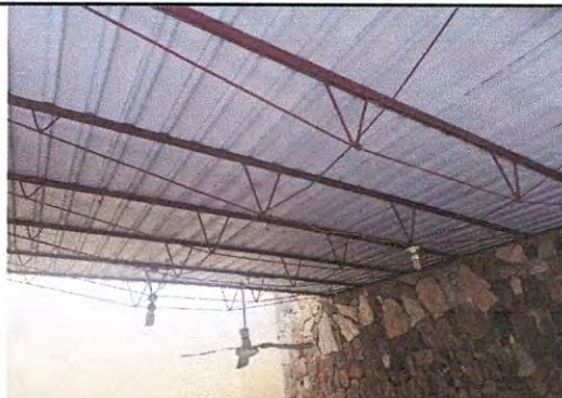
Foto 9: Sustitución de Plafoneras con sus focos
