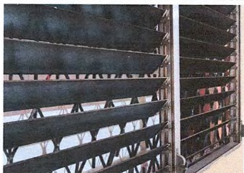
Foto 15: Sustitución de Ventanas de Paleta a PVC
