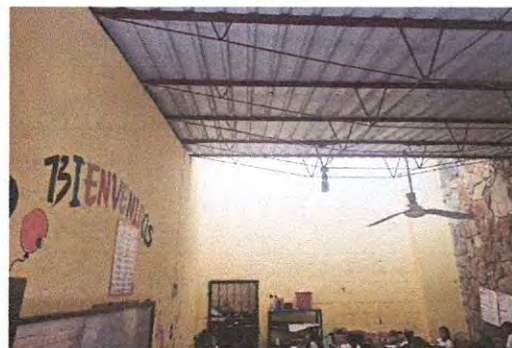
Foto 8: Sustitución de Plafoneras con sus focos
