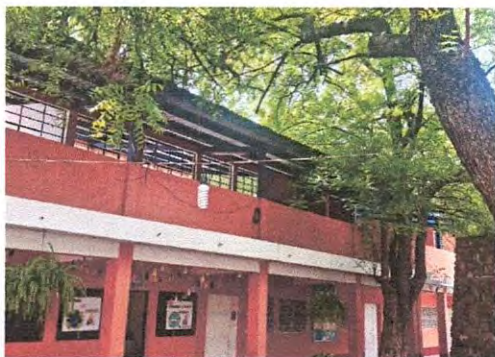
Foto 7: Reparación de Cableado eléctrico
