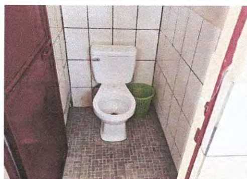
Foto 18: Sustitución de 10 kit de Sanitarios
