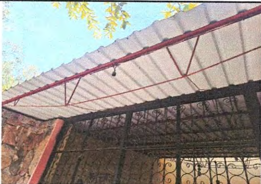
Foto 3: Sustitución de Plafoneras con sus focos
