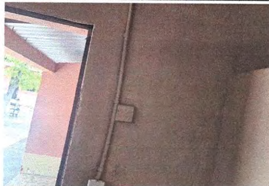
Foto 6: Reparación de Cableado eléctrico
