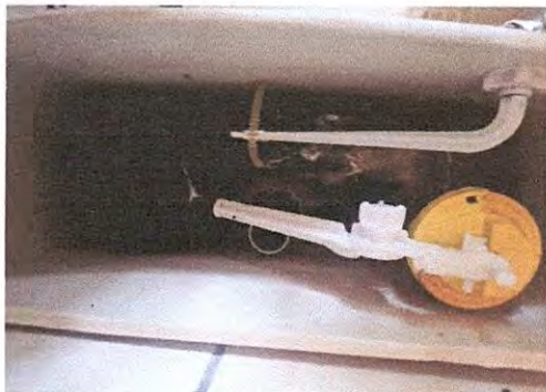
Foto 19: Sustitución de 10 kit de Sanitarios
