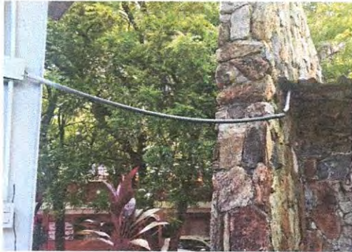
Foto 31: Sustrucción de fexitubo
