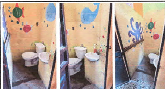
Foto1: 1.1 SUSTITUCIÓN DE INODORO, SUSTITUCIÓN DE AZULEJO Y SUSTITUCIÓN DE PISO CERÁMICO
