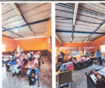
Foto 3: 2.1 Foto 2: 1.2 SUSTITUCIÓN DE LÁMINA TROQUELADA ALUZINC CAL 26, MANTENIMIENTO A ESTRUCTURA DE SOPORTE DE METAL, LIJADO Y PINTADO, SUMINISTRO E INSTALACIÓN DE CANAL DE METAL, PARA AGUA PLUVIAL
