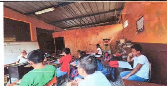
Foto 6: 2.1 Foto 2: 1.2 SUSTITUCIÓN DE LÁMINA TROQUELADA ALUZINC CAL 26, MANTENIMIENTO A ESTRUCTURA DE SOPORTE DE METAL, LIJADO Y PINTADO, SUMINISTRO E INSTALACIÓN DE CANAL DE METAL, PARA AGUA PLUVIAL
