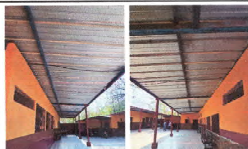
Foto 2: 1.2 SUSTITUCIÓN DE LÁMINA TROQUELADA ALUZINC CAL 28, MANTENIMIENTO A ESTRUCTURA DE SOPORTE DE METAL, LIJADO Y PINTADO, SUMINISTRO E INSTALACIÓN DE CANAL DE METAL, PARA AGUA PLUVIAL
