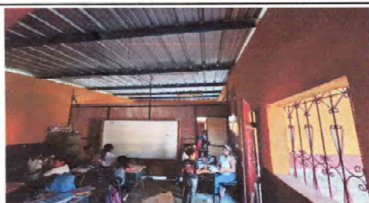
Foto 5: 2.1 Foto 2: 1.2 SUSTITUCIÓN DE LÁMINA TROQUELADA ALUZINC CAL 26, MANTENIMIENTO A ESTRUCTURA DE SOPORTE DE METAL, LIJADO Y PINTADO, SUMINISTRO E INSTALACIÓN DE CANAL DE METAL, PARA AGUA PLUVIAL
