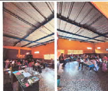
Foto 4: 2.1 Foto 2: 1.2 SUSTITUCIÓN DE LÁMINA TROQUELADA ALUZINC CAL 26, MANTENIMIENTO A ESTRUCTURA DE SOPORTE DE METAL, LIJADO Y PINTADO, SUMINISTRO E INSTALACIÓN DE CANAL DE METAL, PARA AGUA PLUVIAL
