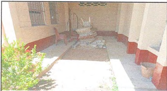
REPARACION DE PISO DE TORTA DE CONCRETO
