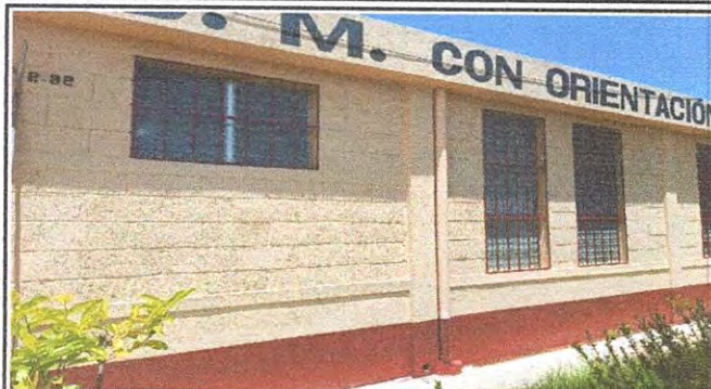
SUSTITUCION DE 7 VENTANAS DE ALUMINIO POR VENTANAS DE PVC COLOR BLANCO AREA SALA DE MAESTROS DE DIFERENTES MEDIDAS, Y SUSTITUCION DE VENTANAS EXISTENTES
