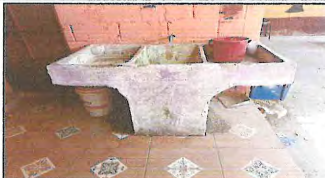
SUSTITUCION E INSTALACION DE PILA PREFABRICADA DE 2 LAVADEROS POR PILA PREFABRICADA DE 2 LAVADEROS
