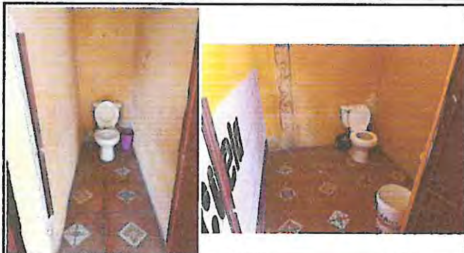
SUMINISTRO E INSTALACION DE SANITARIOS DE BUEN ACALIDAD DE UNA SOLA PIEZA TIPO PUSH.
