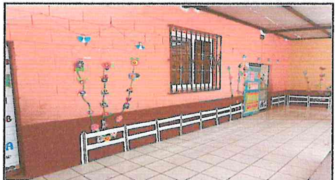
SUMINISTRO E INSTALACION DE PINTURA EN AULAS EN INTERIOR Y EXTERIOR
