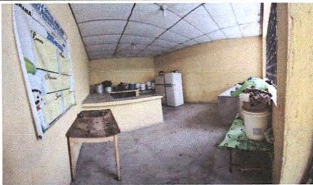
5.1. Suministro e instalación de piso cerámico
