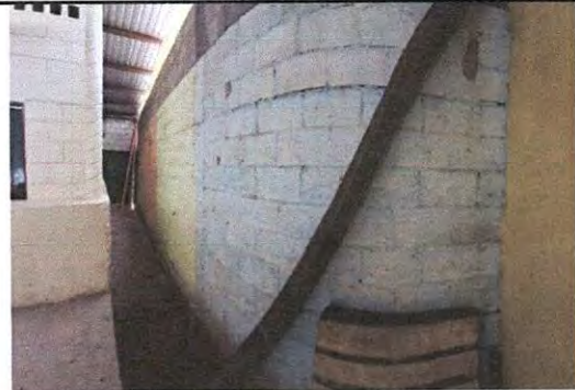
6.1. Fundición de rampa para la salida de emergencia.
