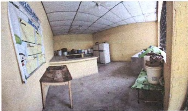
5.1. Suministro e instalación de piso cerámico
