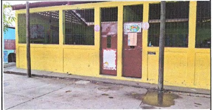
4.2. Reposición de ambas puertas de metal. (Módulo de 3 aulas)
