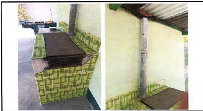
SUSTITUCION DE ESTUFA RURAL CON SU CHIMENEA Y PLANCHA
