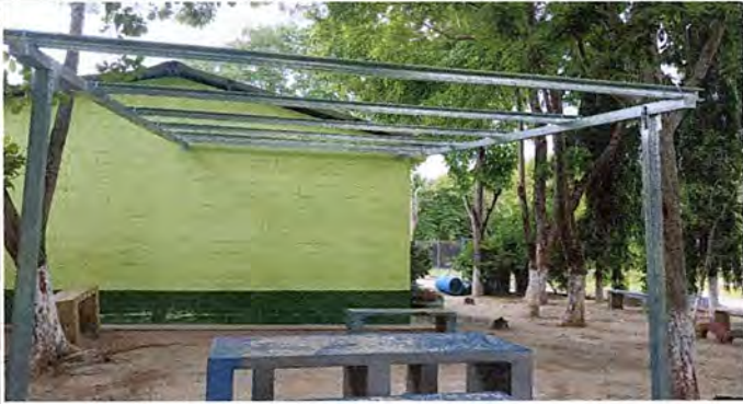
SUMINISTRO E INSTALACION DE LAMINA TROQUELADA DE ALUZINC CALIBRE 26 EN AREA PATIO
