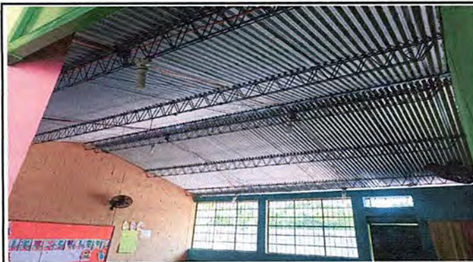
SUMINISTRO E INSTALACION DE CIELO FALSO DE FIBROCEMNETO EN AULAS, INSTALACION DE LAMPARAS LED REDONDAS DE 24 W. DE BUENA CALIDAD INCRUSTADAS EN CIELO FALSO, INCLUYE SU INSTALACION ELECTRICA
