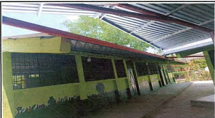
SUMINISTRO E INSTALACION DE CANAL DE METAL AREA FRONTAL DE AULAS Y INSTALACION DE BAJADAS DE AGUA PLUVIAL
