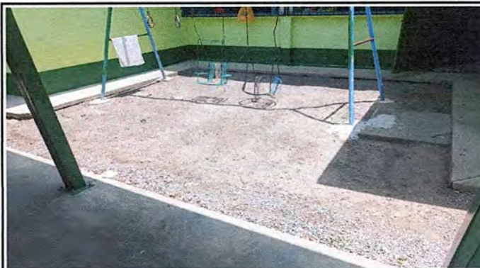
SUMINISTRO E INSTALACION DE PISO DE TORTA DE CEMENTO CON ACABADO FINO AREA DE CULUMPIOS
